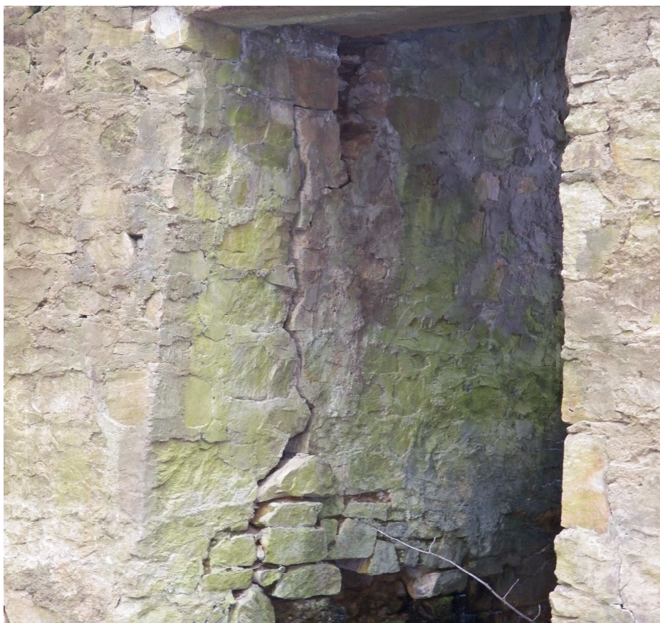
Rysunek 32.A. Rysunek przedstawiający pęknięcia konstrukcji jazy (widok od strony wody dolnej)
