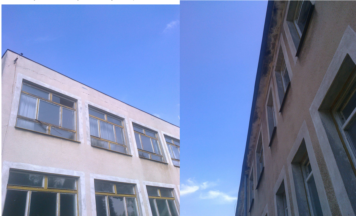
Fot.2 Zarysowanie attyki i korozja okapu
