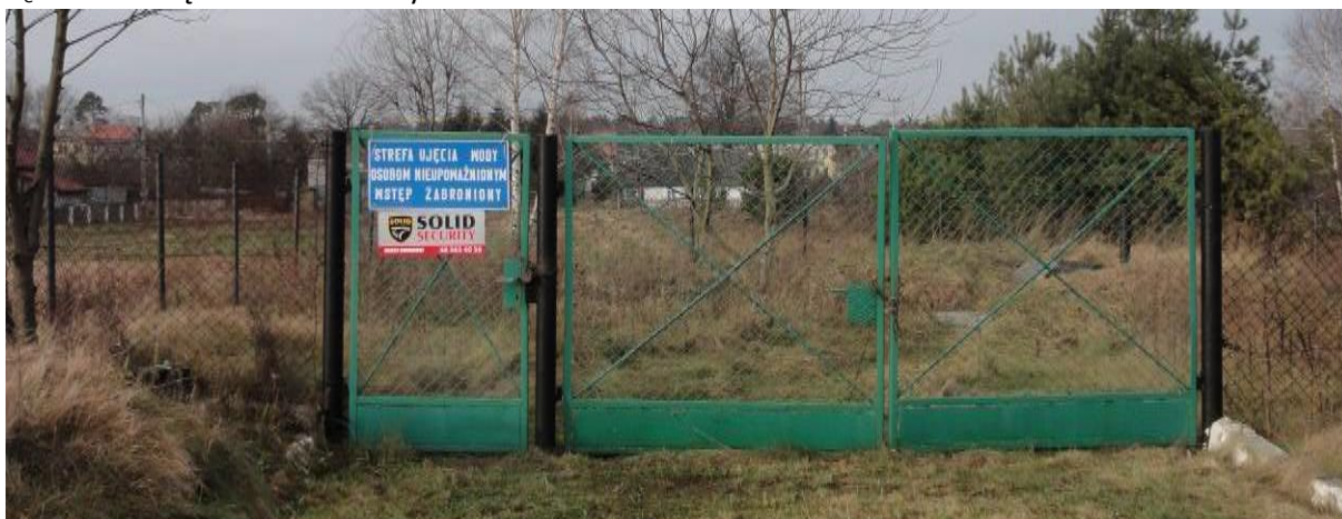
Fot. 1 Ujęcie wody podziemnej w granicach terenu opracowania wraz ze strefą ochrony bezpośredniej (fot. Magdalena Smoczyńska, listopad 2014)
