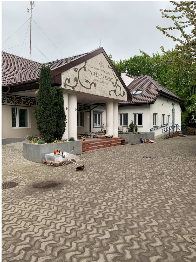
fot. 2. Elewacja wejściowa w dniu opracowania
