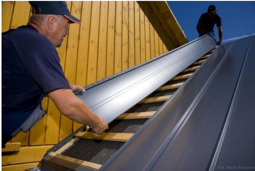
Rys. 2 Układanie blachy na łątach
