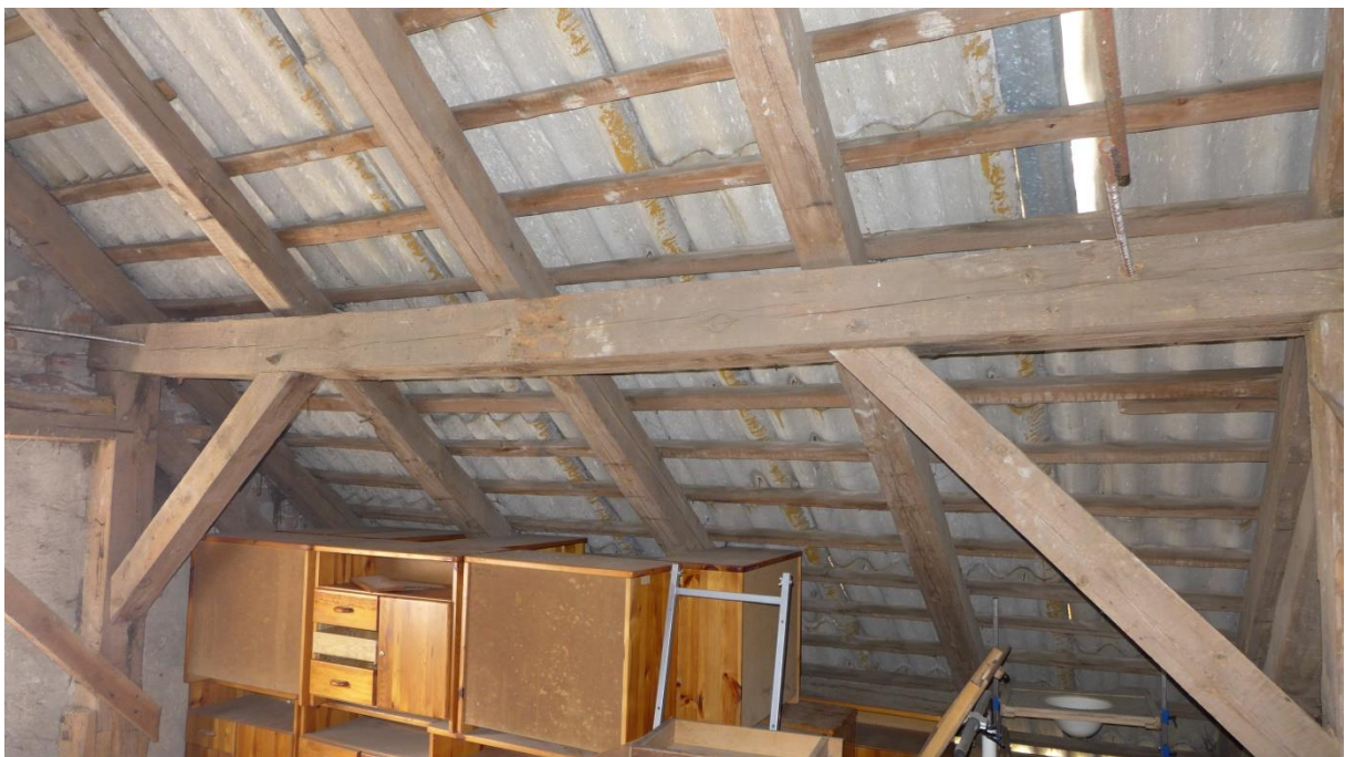
Fot. 8. Przeciążona i nadmiernie ugięta płatew C/21-25.
