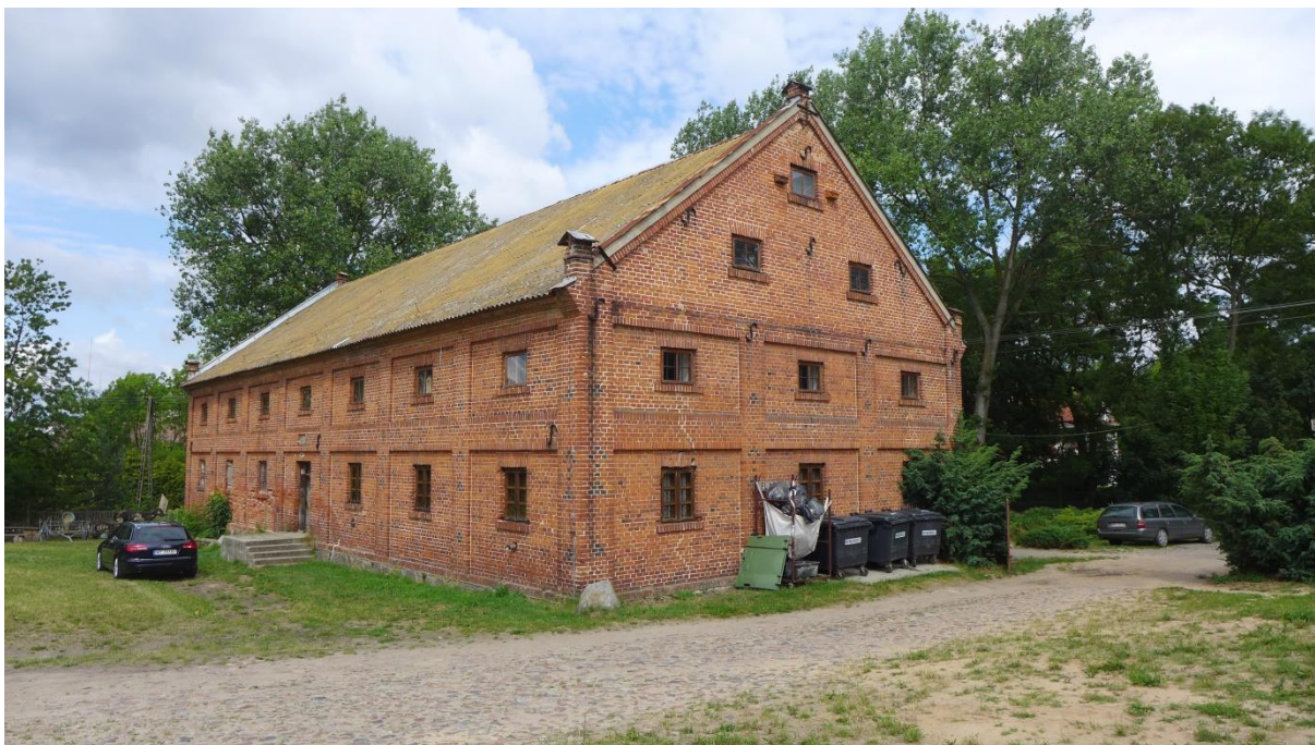
Fot. 21. Ogólny widok obiektu od strony południowo – wschodniej.
