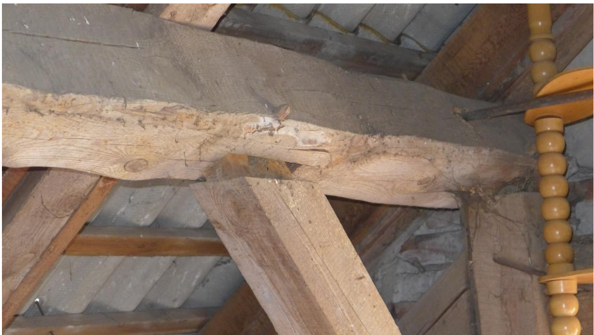
Fot. 10. Widok oparcia płatwi B/21-25 na słupie i mieczu.
