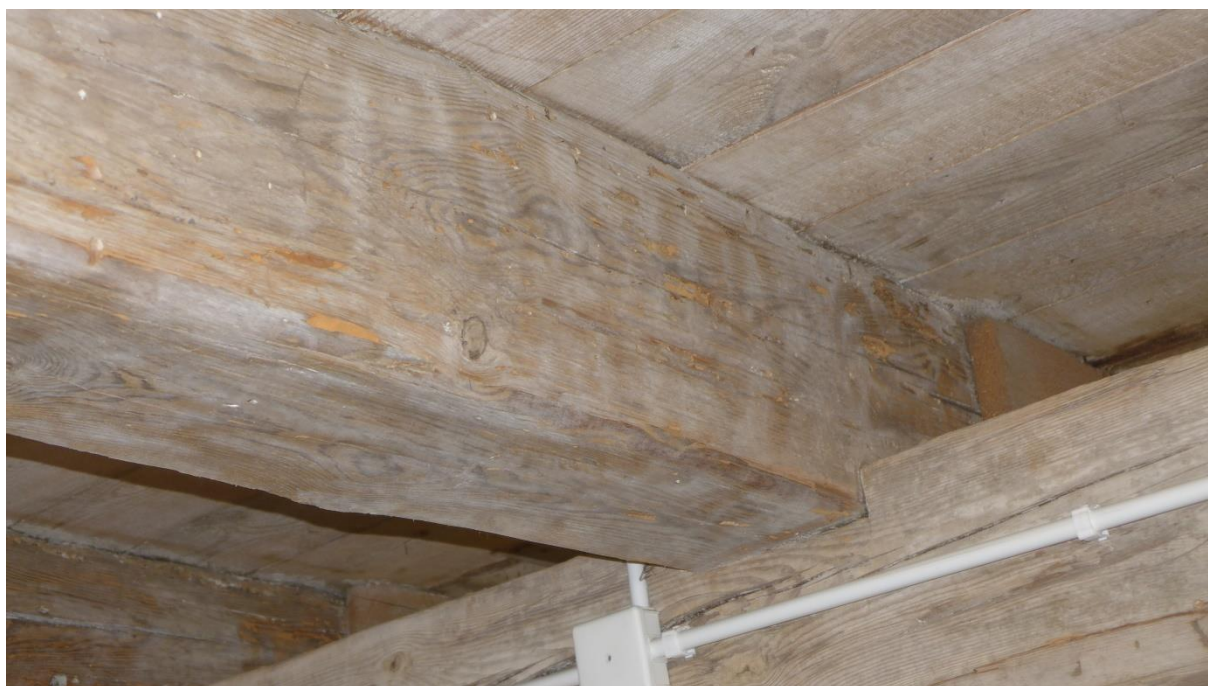
Fot. 18. Przykładowe oparcie belki stropowej na podciągu w części wschodniej; liczne otwory wylotowe spuszczała w belce.
