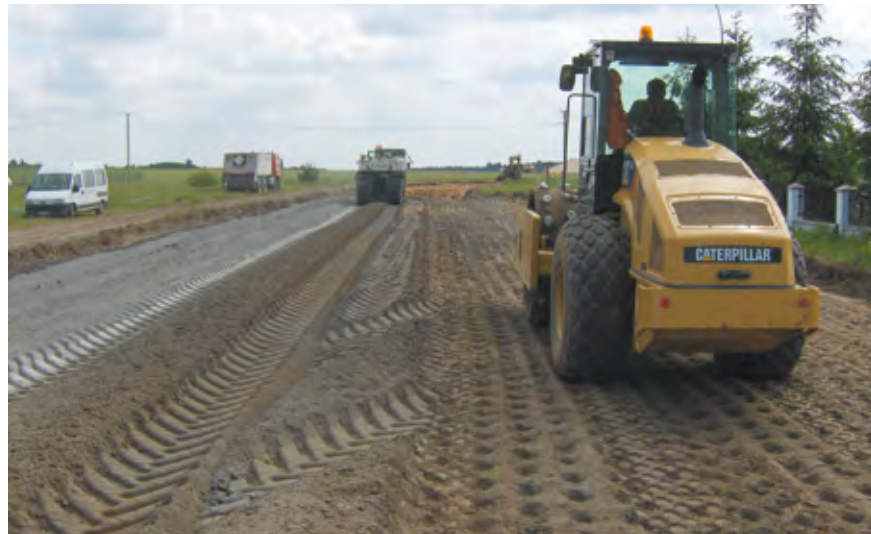
Fot. 1. Wykonanie stabilizacji na placu budowy.
