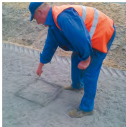
Fot. 2 i 3. Sprawdzenie dozowania spoiwa.
