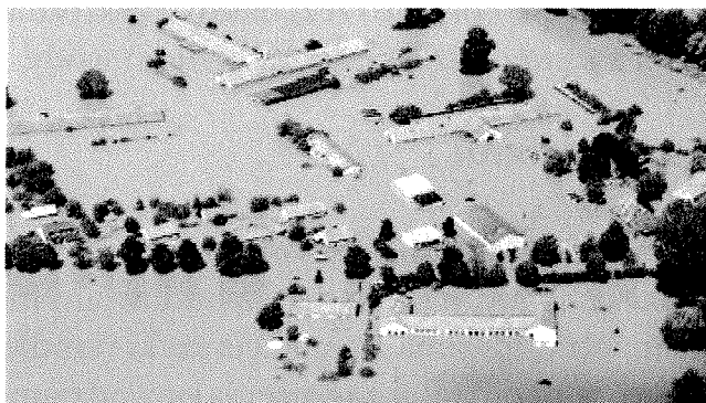
Przerwany wał w Świniarach
