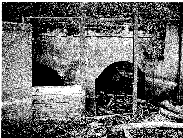
Zniszczony upust roboczy młyna wodnego Przerwa
