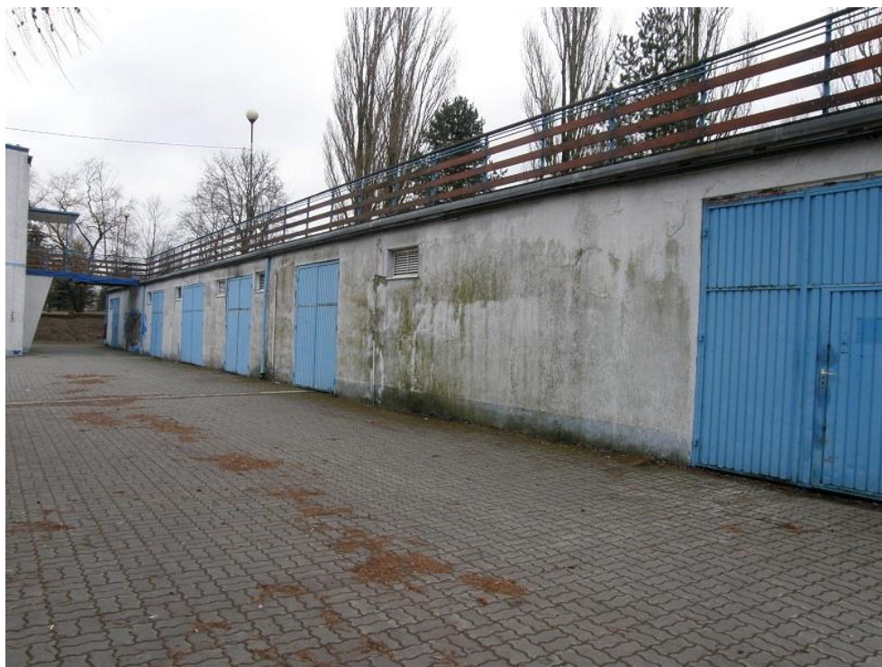
Zdjęcie 8. Budynki magazynowe, hangary i zaplecze socjalne Klubu Żeglarskiego Kormoran (ul. Główna 42)
