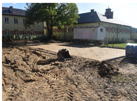
W TRAKCIE BUDOWY
