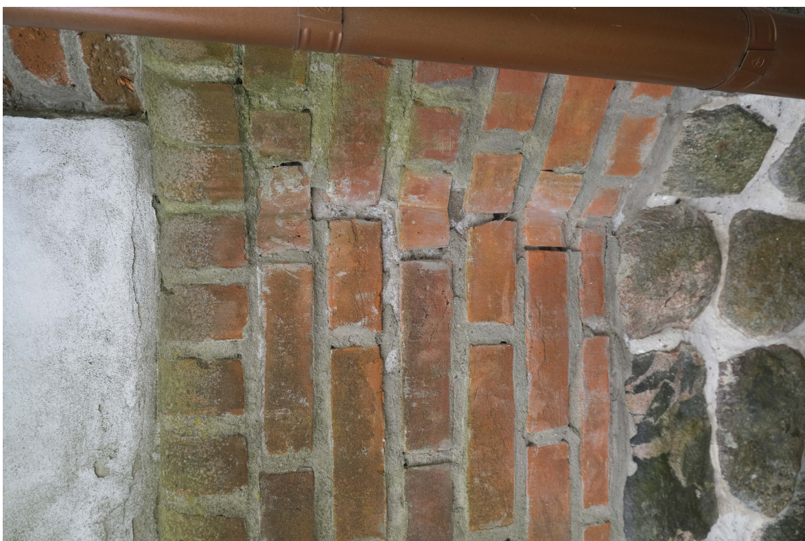
fot. 30. Widok styku szkarpy północno - wschodniej z elewacją północną z widocznymi zniszczeniami wilgociowymi tynku, solno - wilgociowymi spoiny oraz atakiem biologicznym
