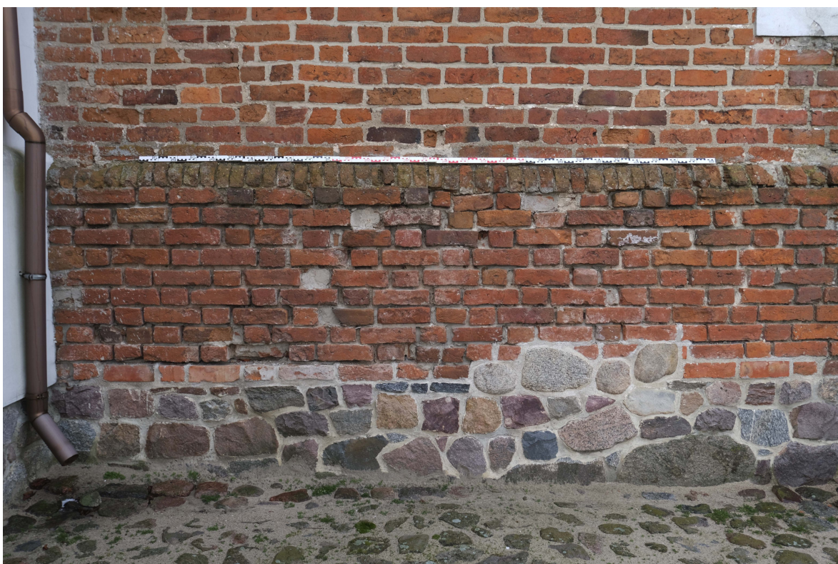
fot. 18. Ceglany cokół elewacji południowej na kamiennym fundamencie - podmurówce
