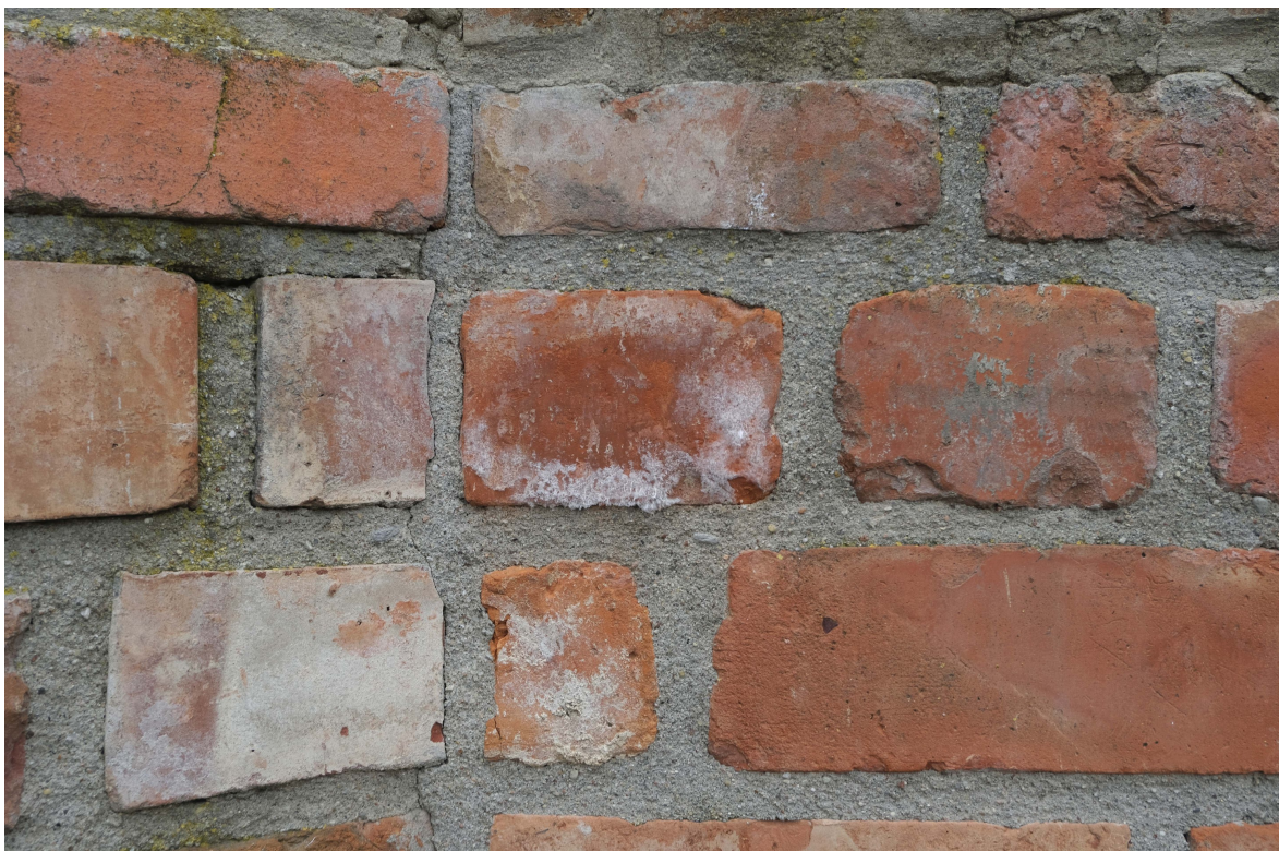
fot. 32. Zniszczenia spoiny oraz wykwyty solne na licu ceglanym elewacji północnej
