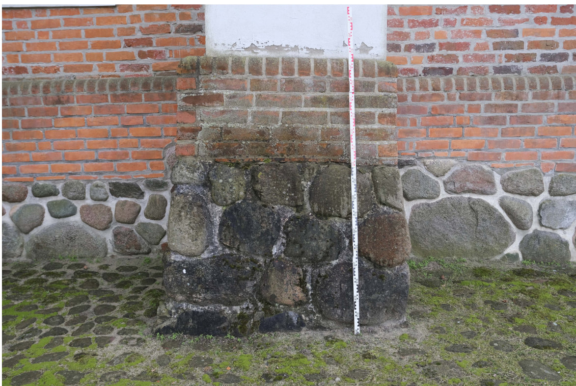
fot. 36. Cokół szkarpy elewacji północnej kościoła ze szczególnie mocno widocznymi zanieczyszczeniami i nawarstwieniami na elementach kamiennych
