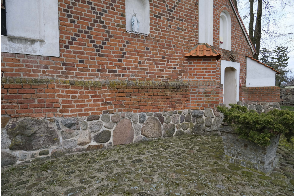
fot. 25. Mieszany : kamienny i ceglany cokół elewacji wschodniej
