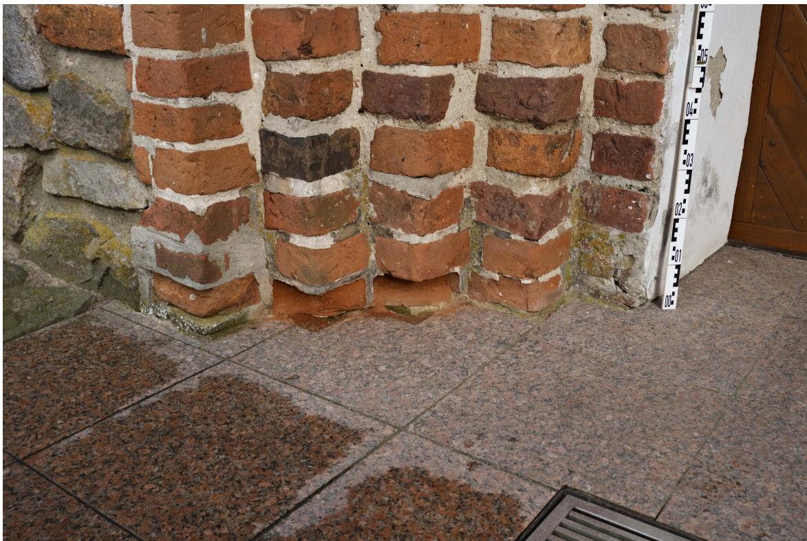
fot. 11. Lewe ościerze portalu elewacji zachodniej : zniszczenia wilgociowo - solne warstw cegły i spoiny u podstawy
