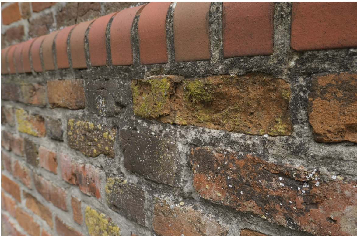
fot. 7. Elewacja zachodnia : przemuirowanie zwieńczenia cokołu kościoła nową klinkierową cegłą maszynową / zniszczenia oryginalnego lica : czarne nawarstwienia, korozja biologiczna oraz destrukcja i lasowanie się materiału
