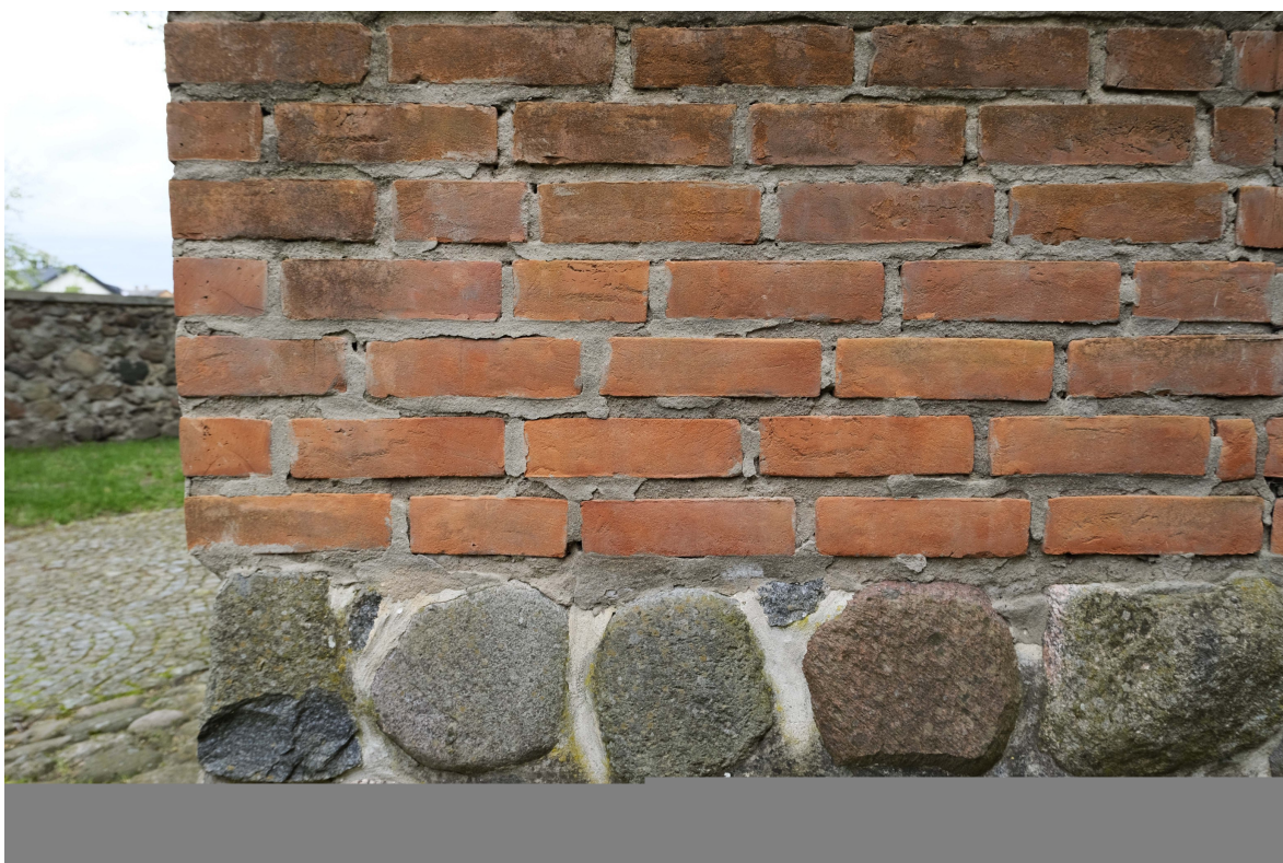
fot. 34. Widok północno - zachodniej szkarpy zakrystii z widocznym rozjaśnionym licem cegły oraz ubytkami spoiny związanymi z działaniem soli rozpuszczalnych w wodzie
