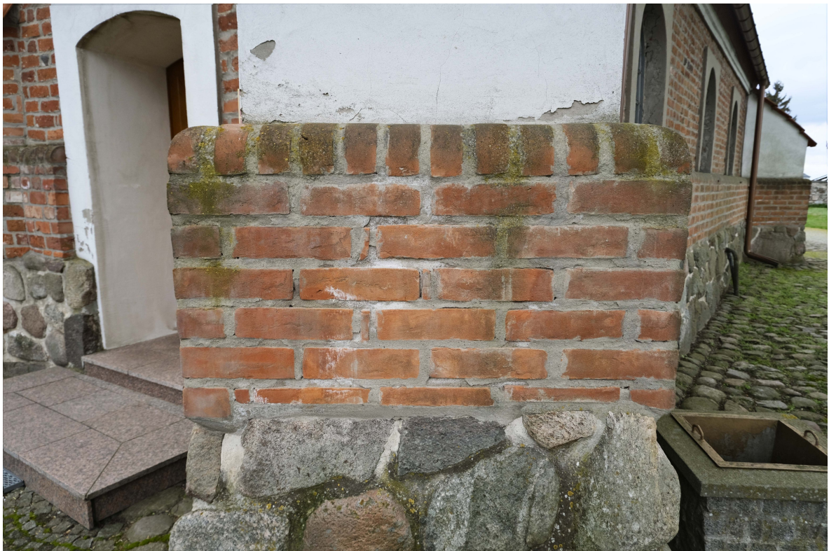
fot. 28. Czoło szkarpy północno - wschodniej z widocznymi zniszczeniami wilgociowymi tynku, solno - wilgociowymi spoiny oraz atakiem biologicznym
