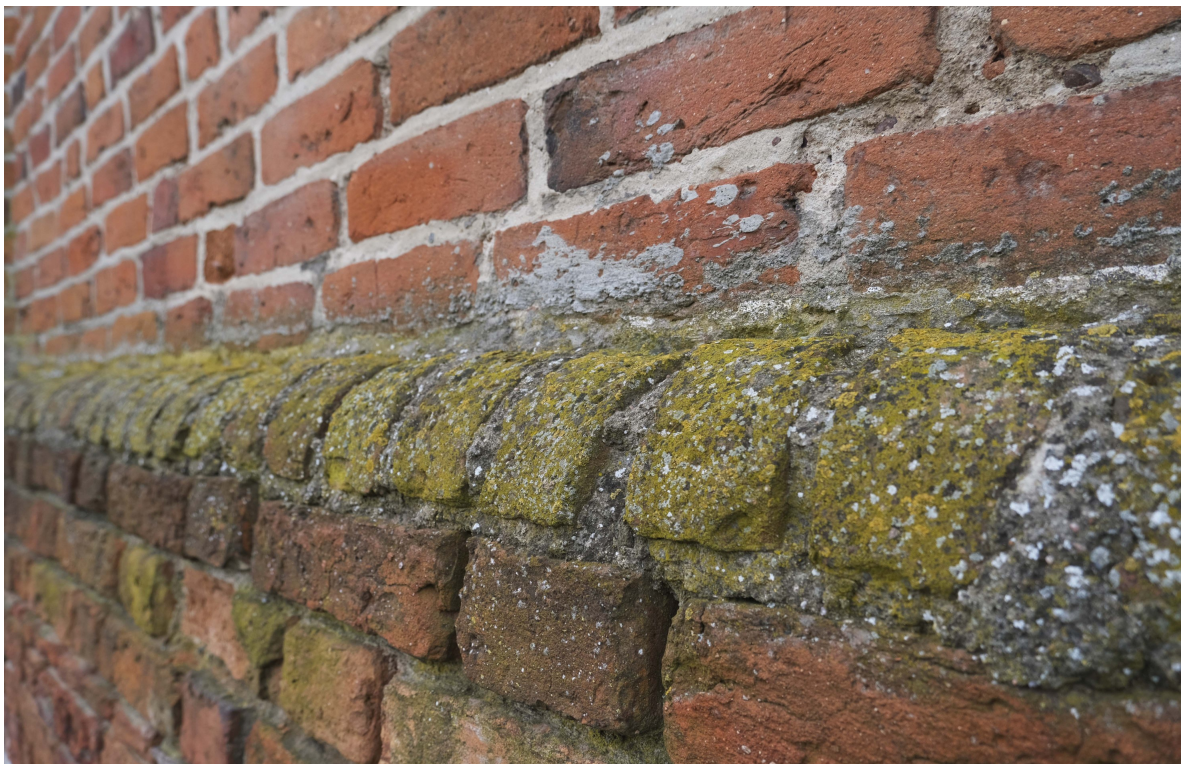
fot. 26. Widok zniszczeń zwieńczenia cokołu: ubytki spoiny i cegły, atak biologiczny oraz zanieczyszczenia lica cegły gotyckiej mleczkiem cementowym
