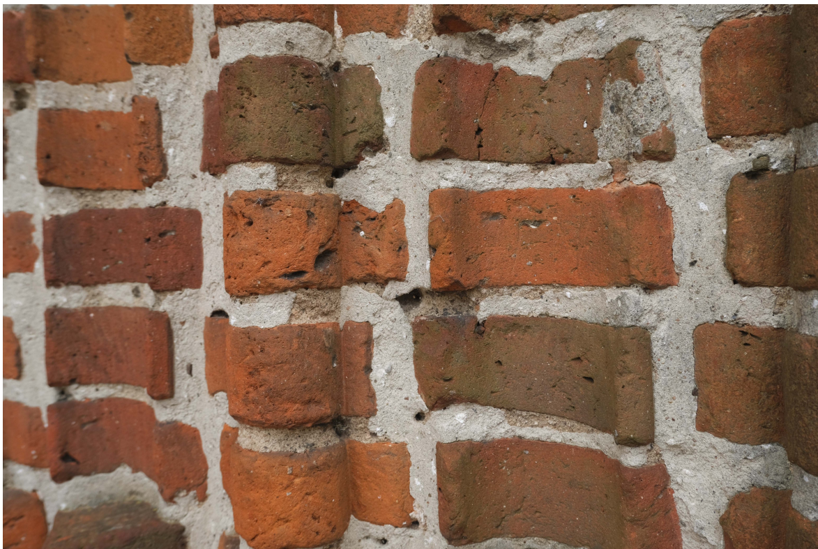
fot. 9. Prawe ościerze portalu elewacji zachodniej - zbliżenie : widoczna dezintegracja oryginalnej spiny i naprawy z czasów współczesnych
