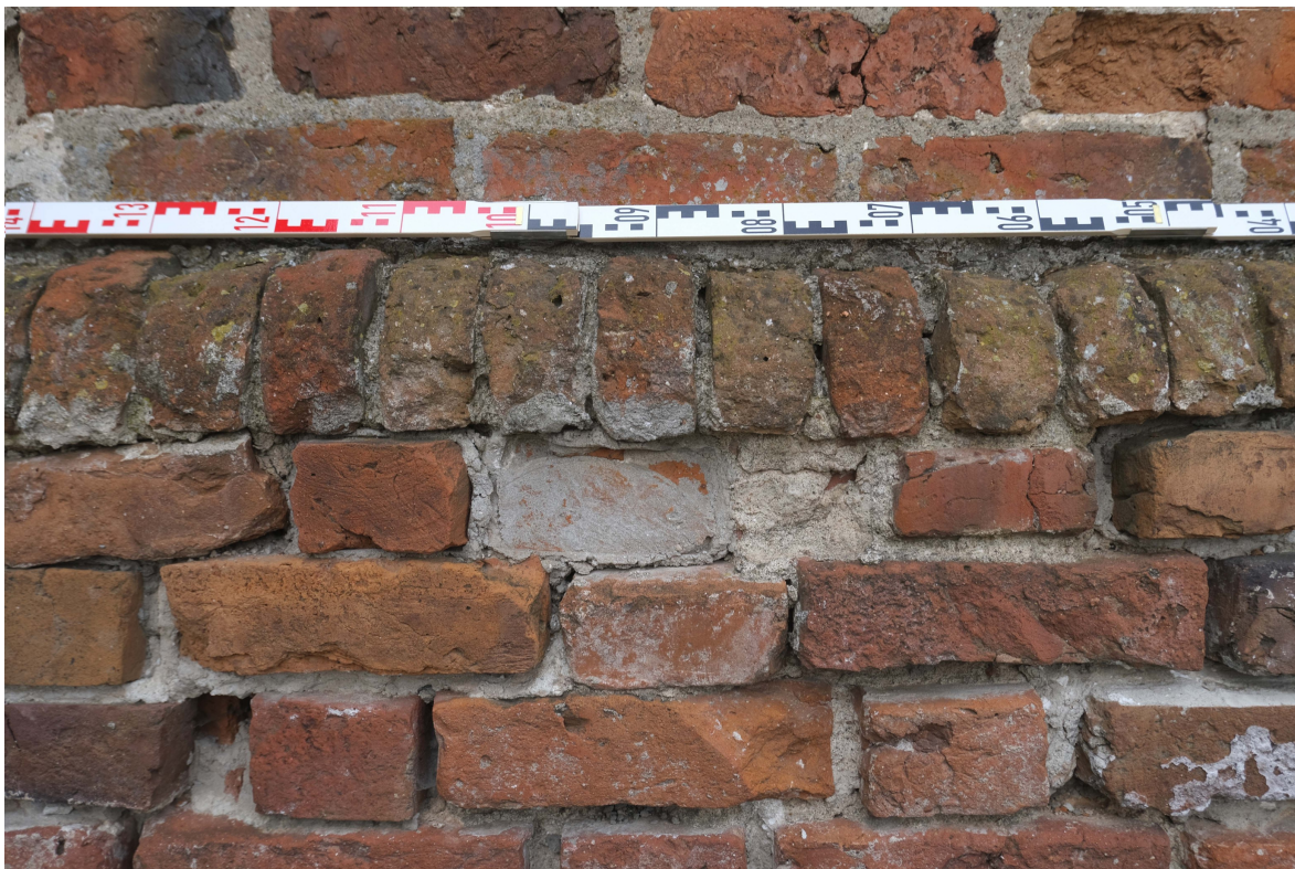
fot. 19. Widok zniszczeń, ubytków spoiny oraz flekowanego lica elewacji południowej kościoła
