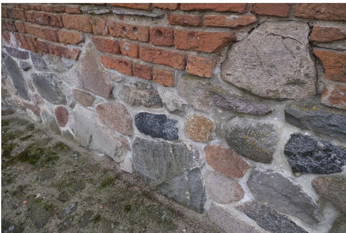
fot. 38. Zbliżenie kamiennego fundamentu – podmurówki kościoła
