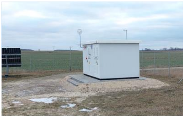
Pic. 3. Prefabrykowana stacja transformatorowa (pochodzenie: źródło własne)
