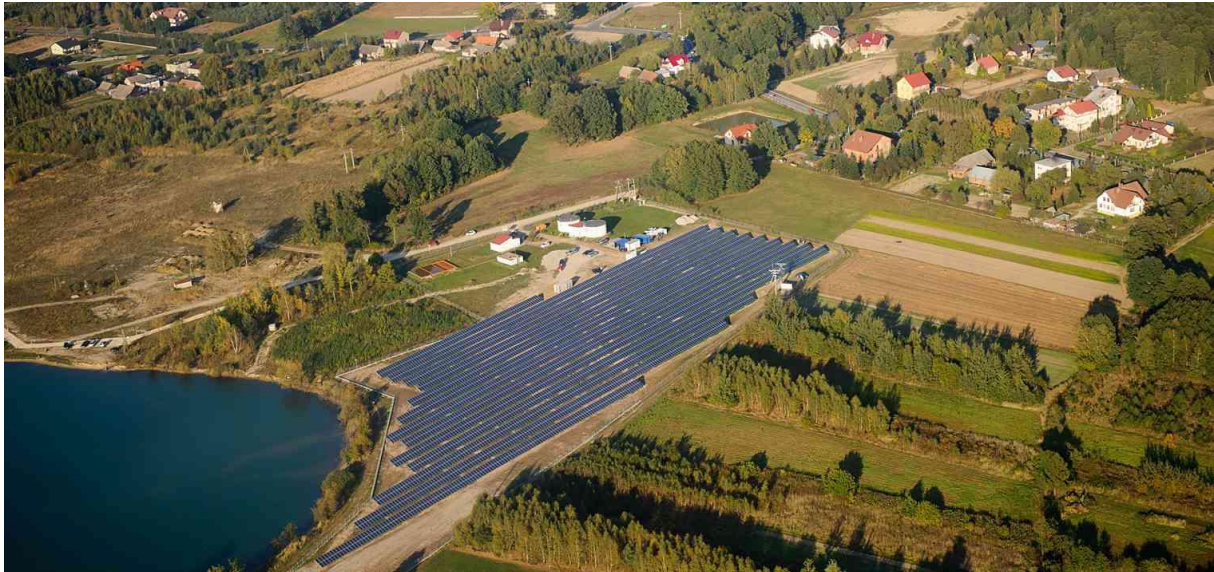
Rys. Instalacja fotowoltaiczna w Wierchosławicach (źródło: http://www.forumfree.pl )
