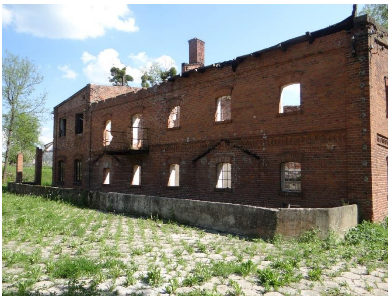
Fot. 1 Pozostałości krochmalni
