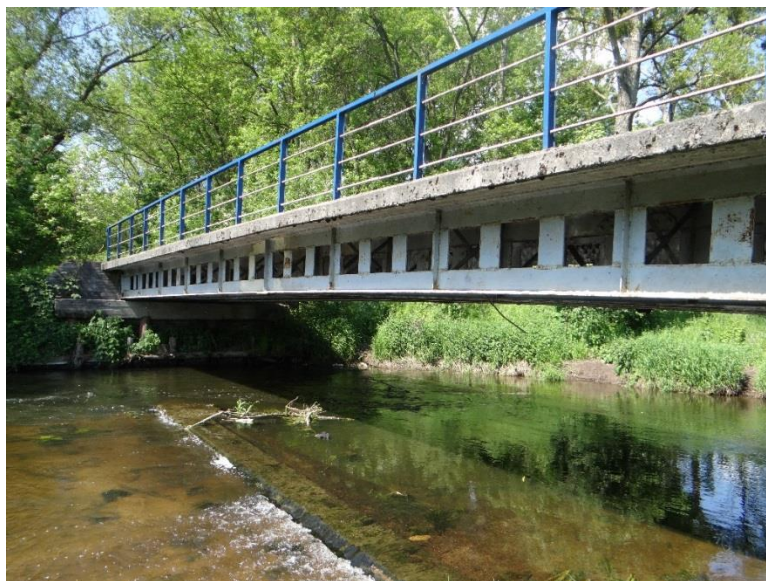
Fot. 2 Most nad rzeką Skrwą
