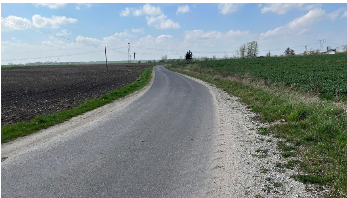
Zdjęcie nr 6. Droga gminna w miejscowości Podwierzbie.
