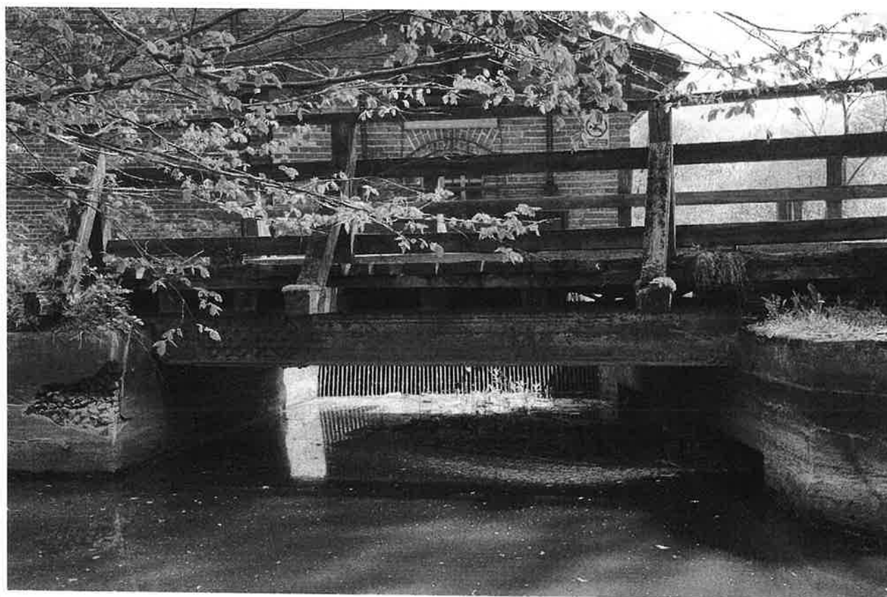
Fot. 6. Widok przęsła nad wodą napływającą na kratę elektrowni
