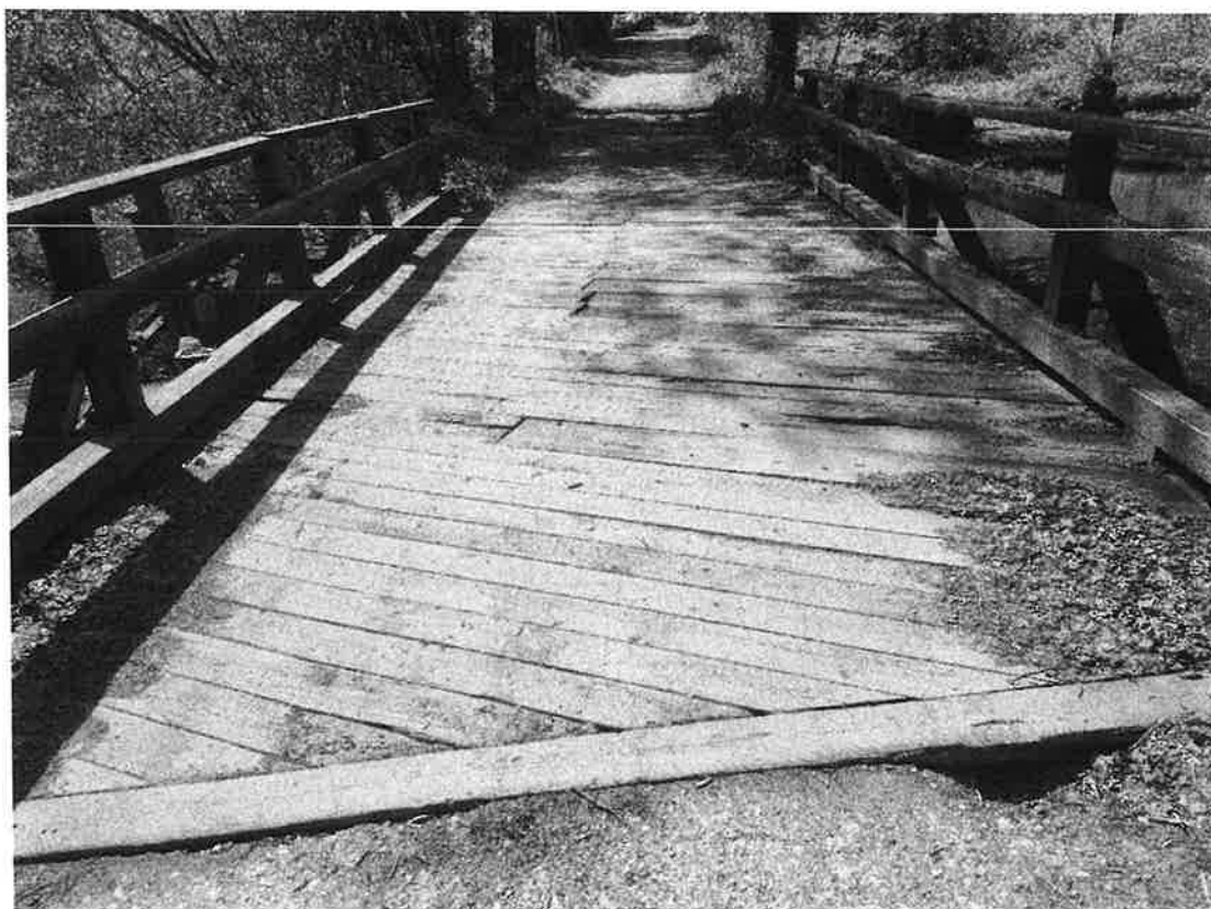
Fot. 3. Widok pomostu od strony starej elektrowni wodnej
