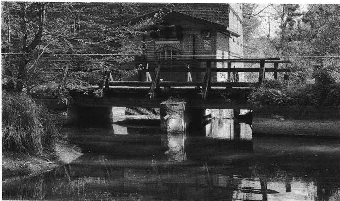
Fot. 5. Widok z boku mostu od strony napływającej wody, wraz z murem oporowym od strony DP 3726W
