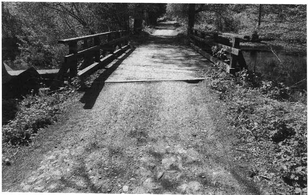
Fot. 2. Najazd na pomost od strony starej elektrowni wodnej
