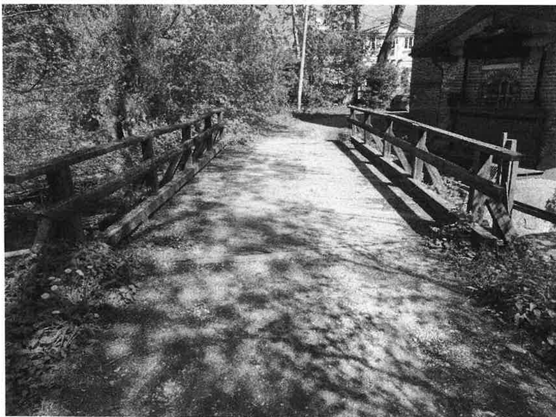
Fot. 4. Dojazd na most od strony DP 3726W
