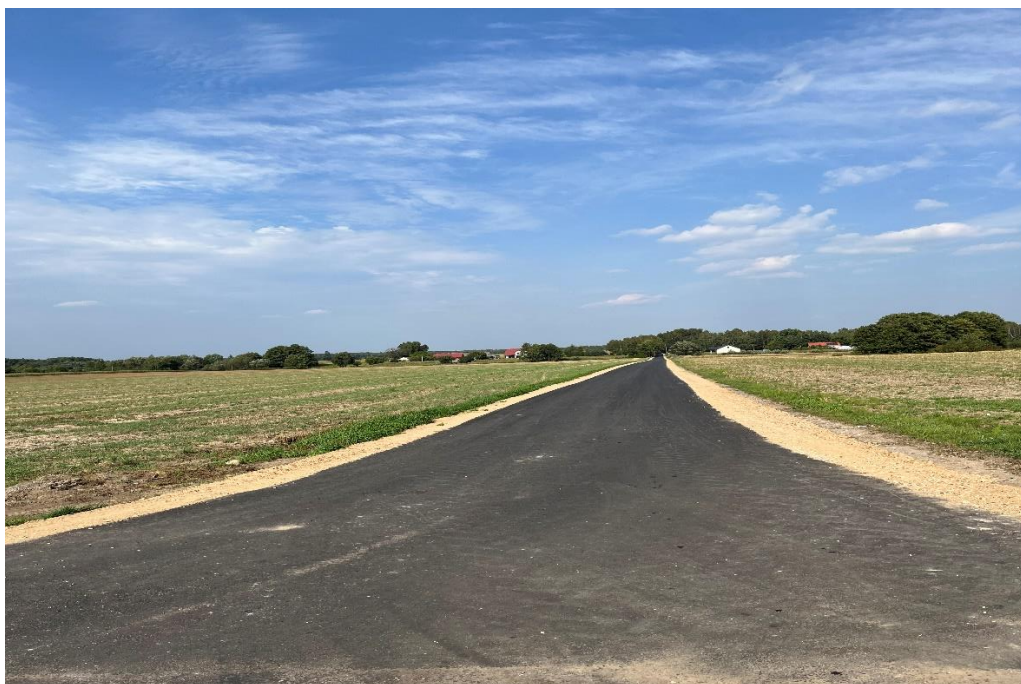
Zdjęcie nr 1. Droga gminna w miejscowości Rachocin
