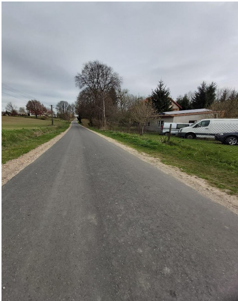
Zdjęcie nr 1. Droga gminna w miejscowości Rydzewo
