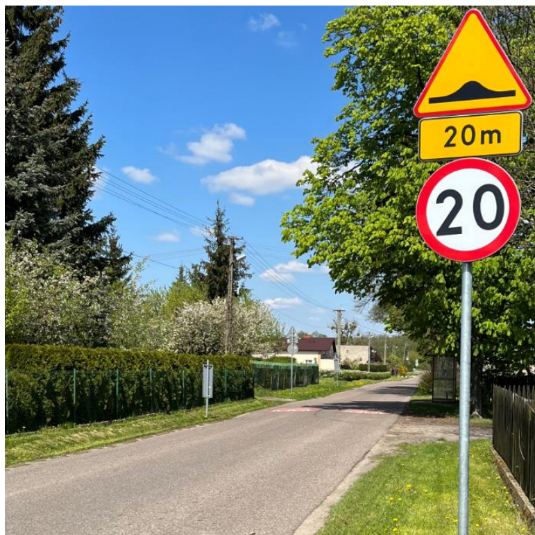
Zdjęcie nr 6. Progi zwalniające w ciągu drogi gminnej nr 370523W w miejscowości Mieszczyk
