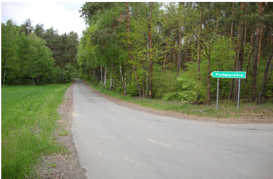
Droga gminna w miejscowości Podwierzbie.
