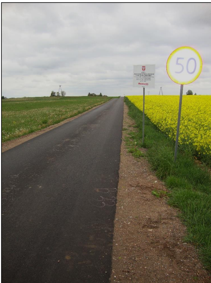
Droga wewnętrzna w m. Kręckowo
