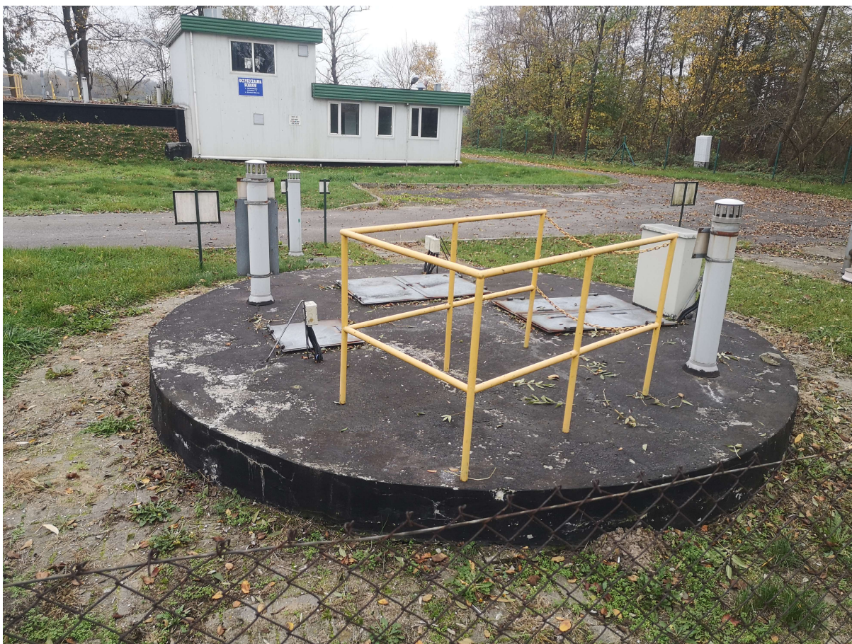
Istniejąca komora zbiorcza ścieków
