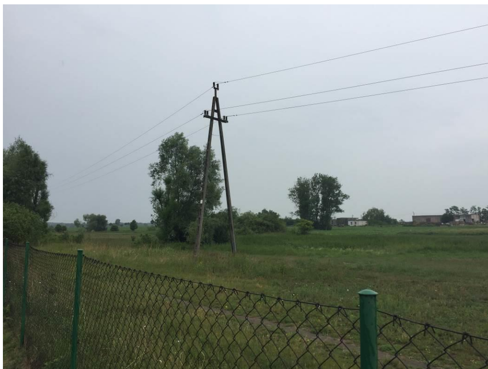
Fot 2. Widok na istniejące ogrodzenie oraz napowietrzną sieć 15kV
