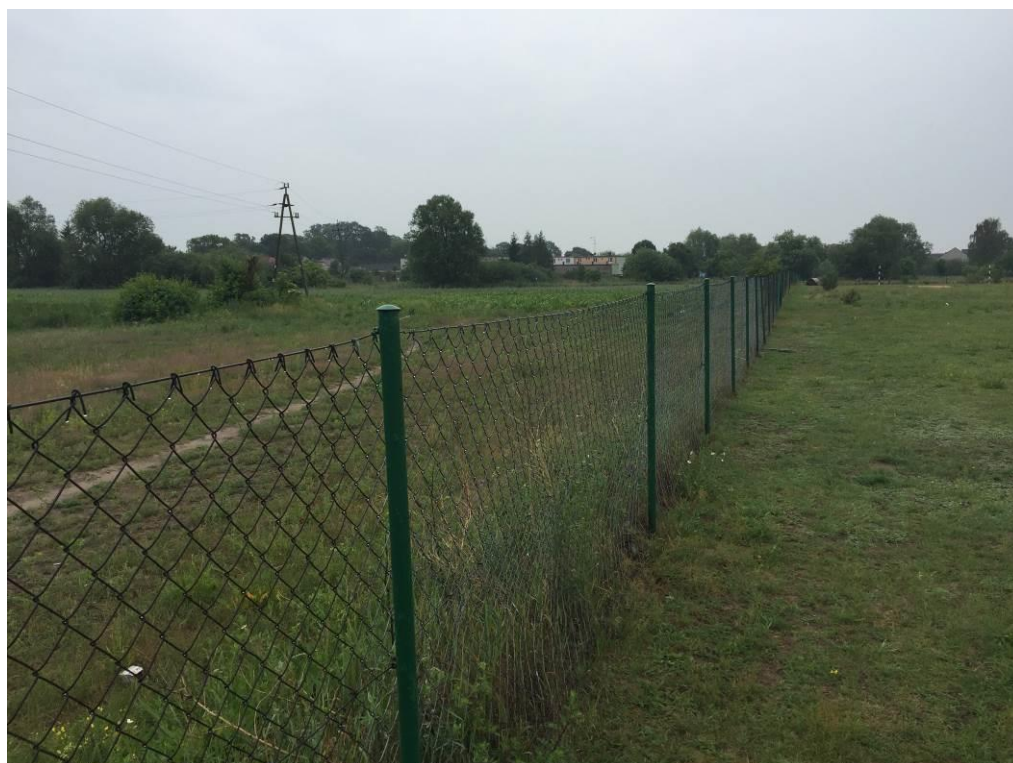
Fot 3. Widoczna istniejące ogrodzenie do rozbiórki
