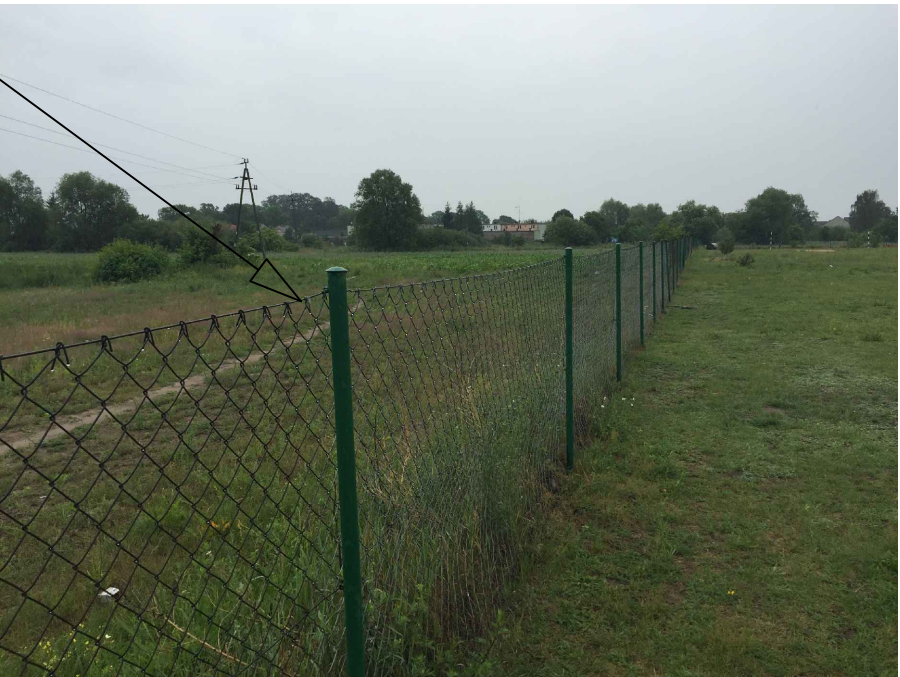
WIDOK NA ISTNIEJĄCE OGRODZENIE Z SIATKI PLECIONEJ DO DEMONTAŻU NA FRAGMENTIE ~50m
