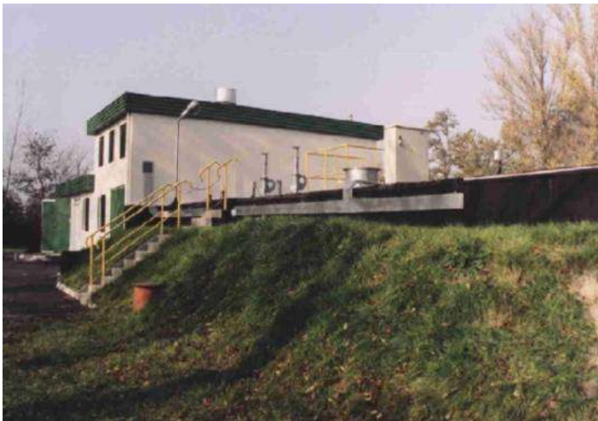
Fot. 9 Oczyszczalnia ścieków komunalnych w Siemionkach (źródło: zasoby Gminy Jeziora Wielkie)
