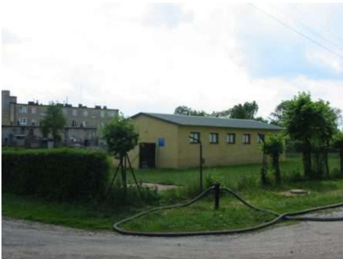
Fot. 5 Budynek ujęcia wody w Kościeszkach
