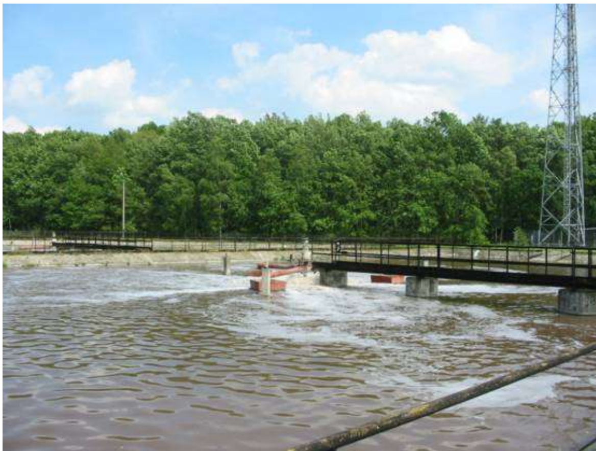
Fot. 8 Widok stawu fakultatywnego, napowietrzanego, będącego elementem ciągu technologicznego w oczyszczalni w Przyjezierzu
