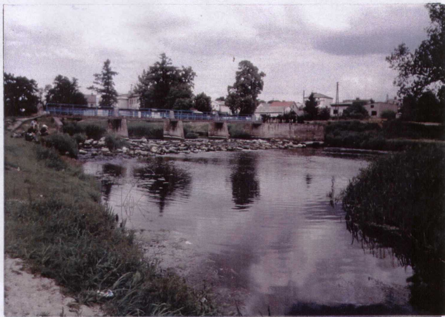
1. Widok kładki byłego jazu w Strzegowie od strony „wody dolnej”.
