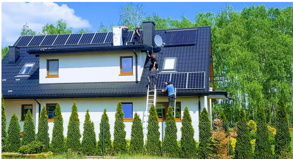
Fot. Montaż instalacji fotowoltaicznej na domu prywatnym
