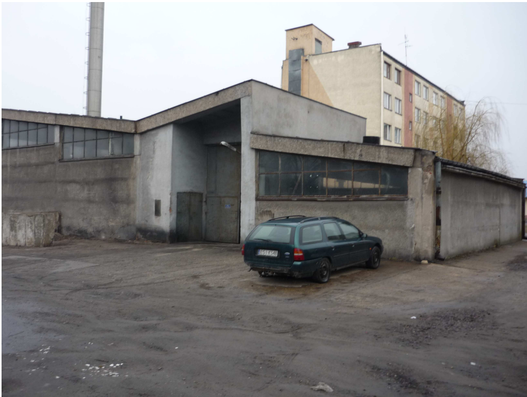
Widok ogólny budynku kotłowni
