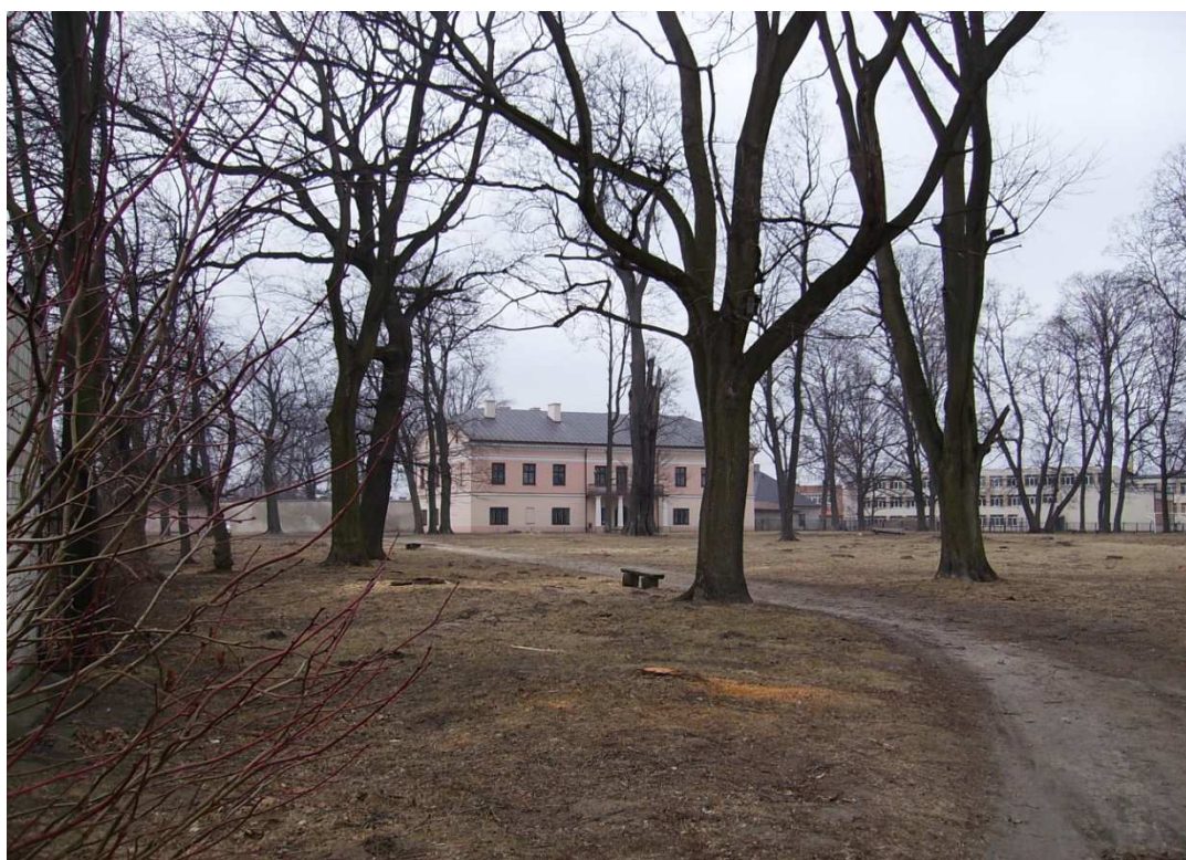
Widok od komory K1 do komory K2
