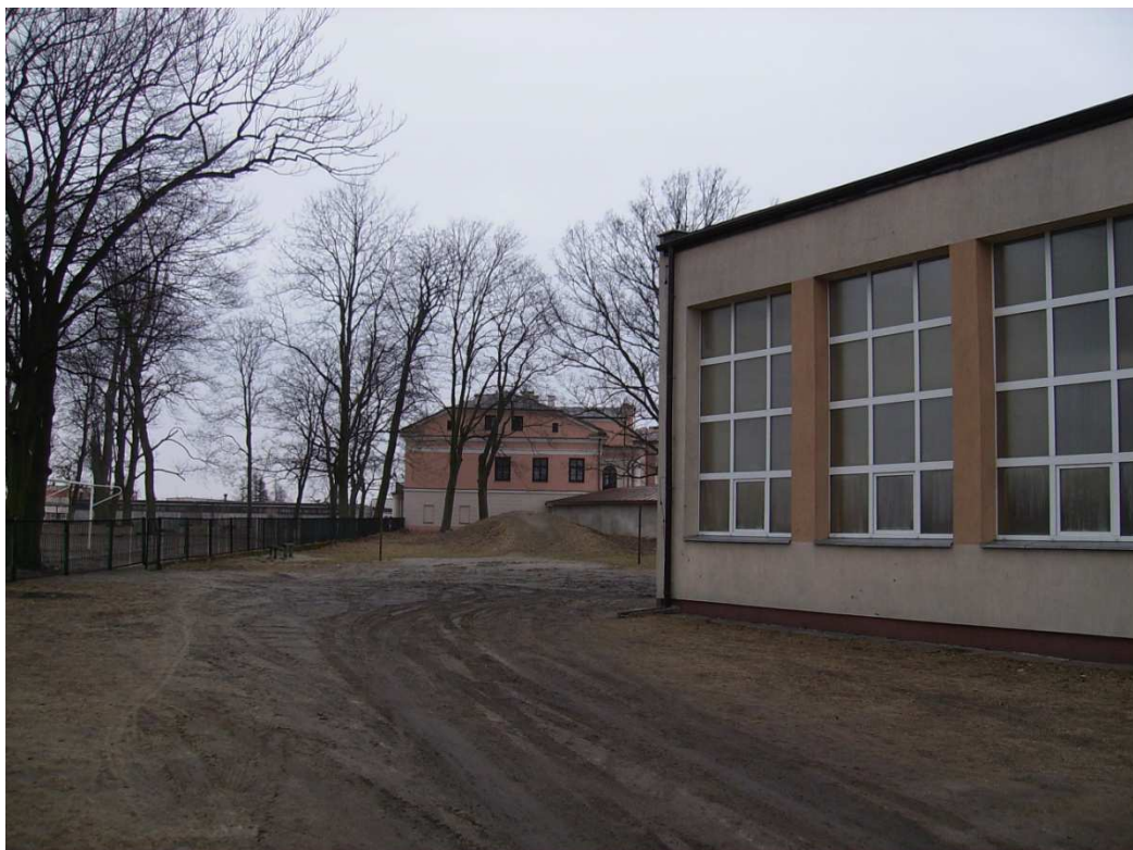
Widok od komory S1 w kierunku budynków 2,3,4
