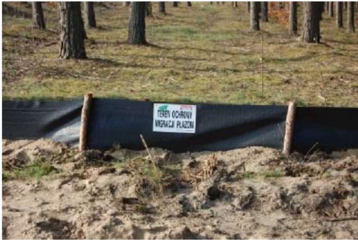
Rysunek 7.1. Ogrodzenie ochronne na czas budowy
