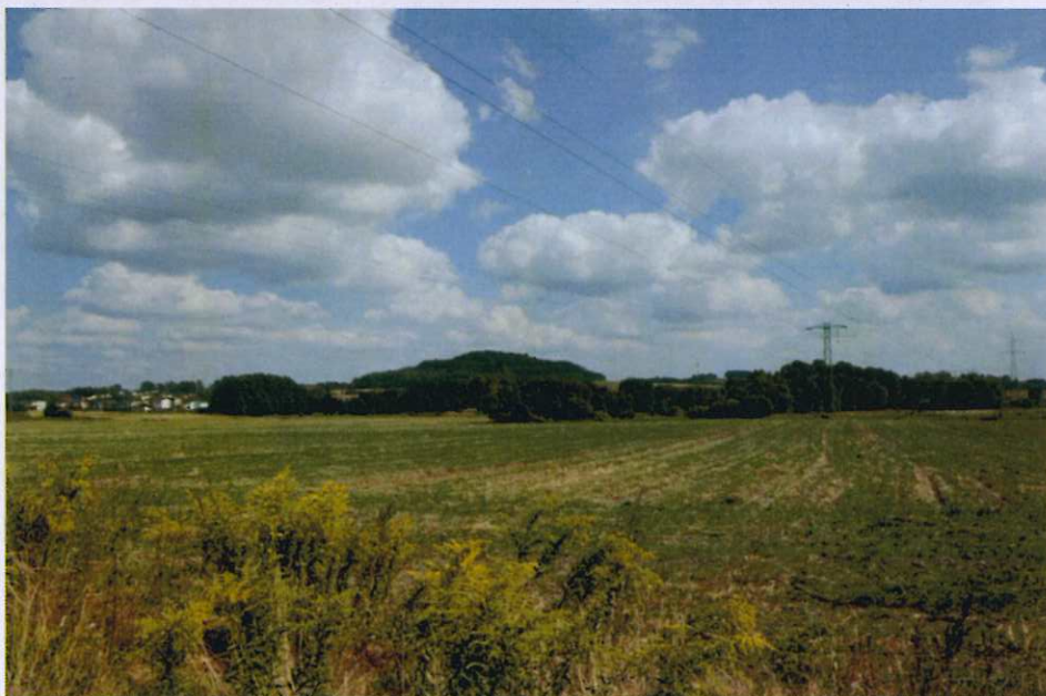
Fot. 44. Linia elektroenergetyczna 110kV w okolicach Psar
