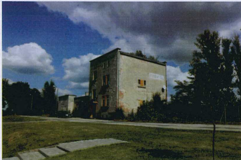
Fot. 42. Dawny budynek stacji kolejowej w Psarach będący w złym stanie technicznym, obecnie znajdują się tam lokale mieszkalne
