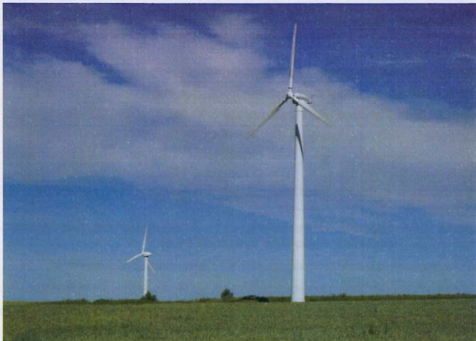
Fot. 45. Elektrownie wiatrowe w okolicy miejscowości Kamienica
