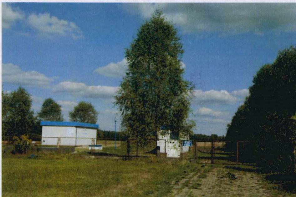
Fot. 43. Ujęcie wody w Pakułach
