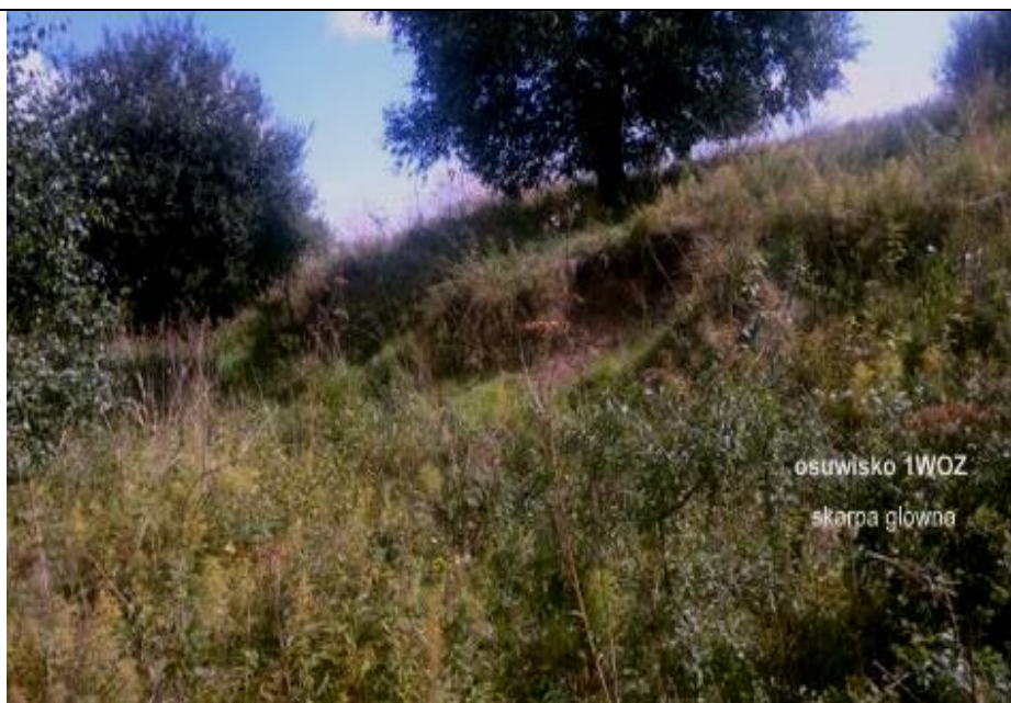
Osuwisko na zachód od miejscowości Mzyki
