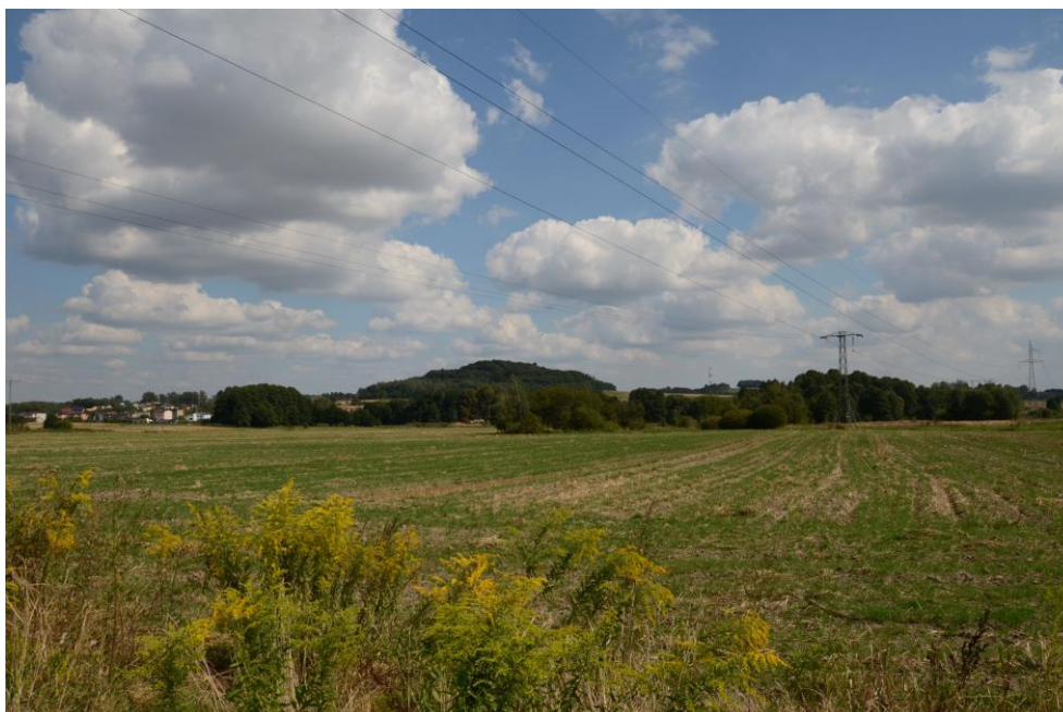
Fot. 44. Linia elektroenergetyczna 110kV w okolicach Psar
