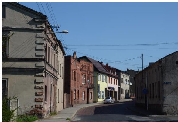
Fot. 2. Zabudowa kamieniczna w Woźnikach
