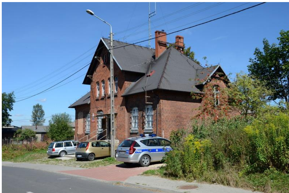
Fot. 39. Budynek komisariatu policji w Woźnikach
