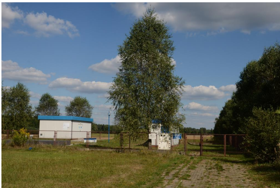
Fot. 43. Ujęcie wody w Pakułach
