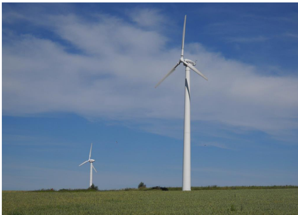
Fot. 45. Elektrownie wiatrowe w okolicy miejscowości Kamienica
