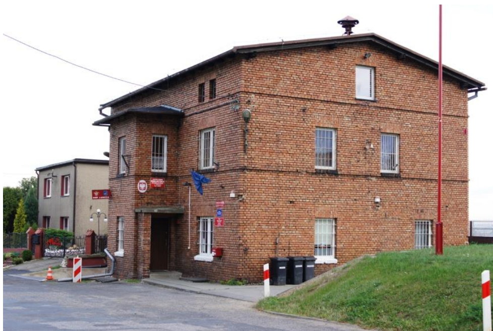
Fot. 35. Filia biblioteki publicznej gminy Woźniki w miejscowości Lubsza (w budynku znajduje się również Poczta i Ochotnicza Straż Pożarna)
