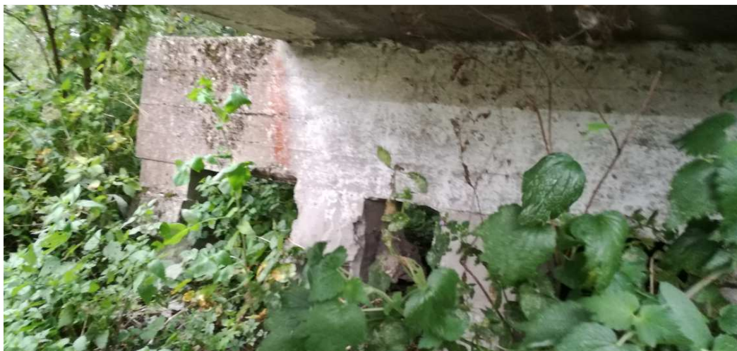
Fot 6 Widok na podporę obiektu- słup-pale żelbetowe zwieńczone oczepem
