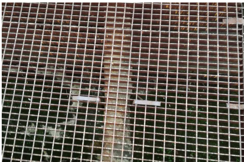
Fot 3 Poprzecznice żelbetowe – widoczna duża degradacja powierzchni betonu
