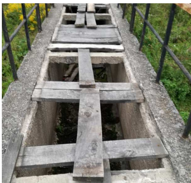
Fot 5 Widok na istniejącą nawierzchnię o konstrukcji drewnianej oraz jej częściowy brak
