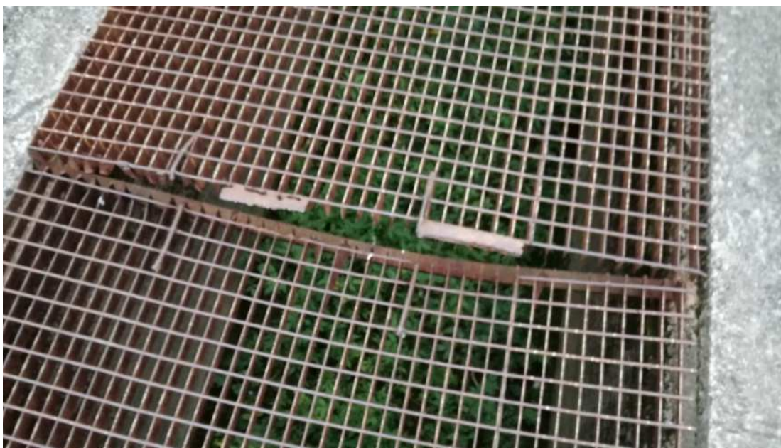
Fot 4 Widok na istniejącą nawierzchnię o konstrukcji stalowej kraty, widoczne odkształcenie kraty w kierunku podłużnym obiektu, brak odpowiedniego podparcia krat, poprzecznic
