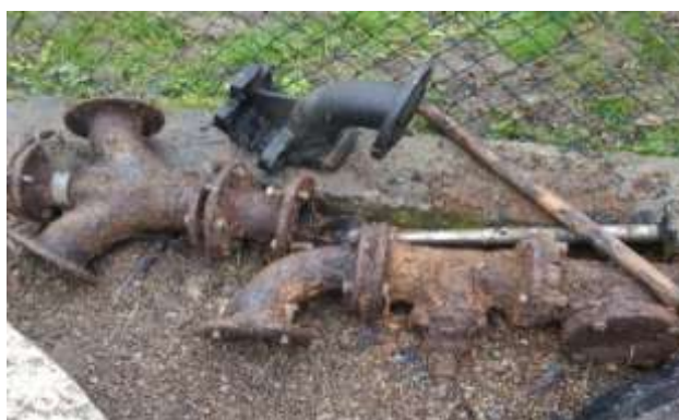
Elementy konstrukcji starej pompowni ścieków P2 w Dunajku.
