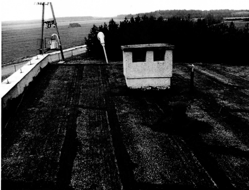
Zdjęcie Z-7 . Pokrycie stropodachu papą asfaltową, cz. wyższa. Wywietrzaki wentylacyjne i nasady, do wymiany. Kotłeniz na kominie z blachy ocynkowanej, za niski.
