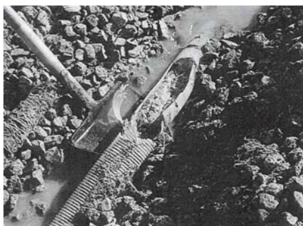
Fot. 1 i 2. Dren rurowy zatkany korzeniami roślin.
