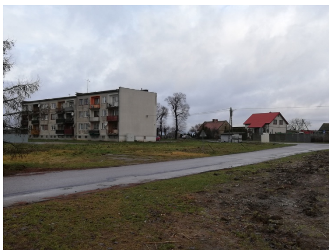
Widok na bloki mieszkalne
