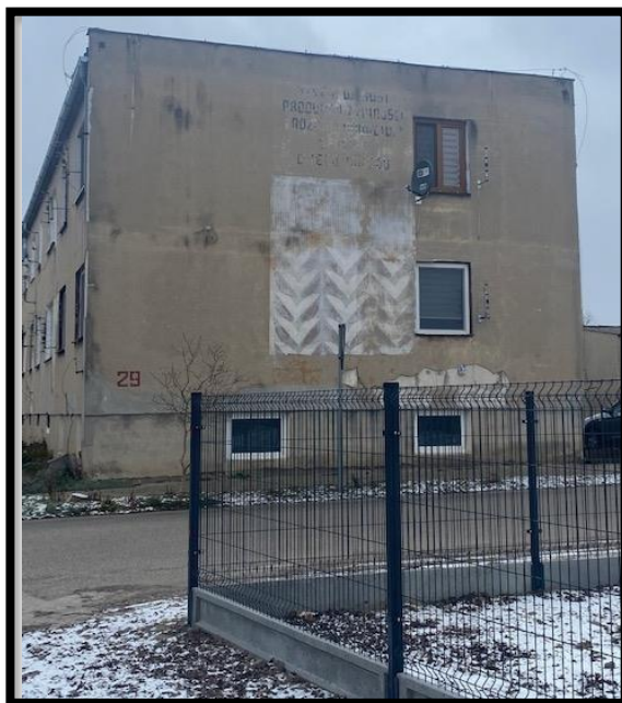
Budynek byłego PGR
