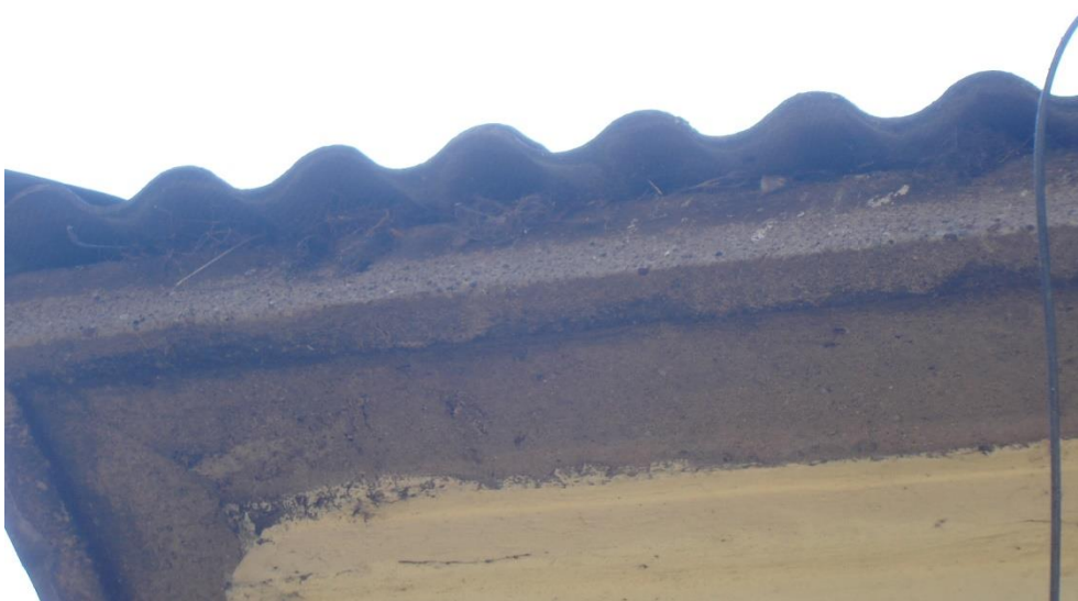
Foto. 4. Wystający spod płyt materiał Fot. Przemysław Kubacki
