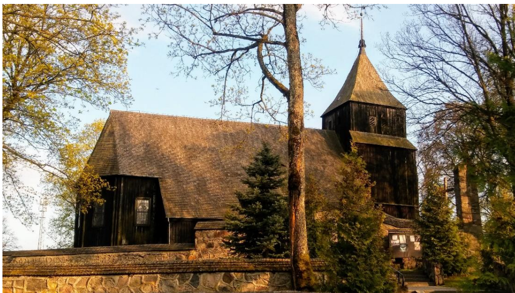
Fot.1. Kościół – widok ogólny
