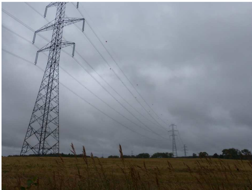
Fot. 8 Linia elektroenergetyczna najwyższych napięć (NN) o napięciu 400kV r relacji Elk Bis – Granica Państwa (Alytus) na terenach gminy Wieliczki
