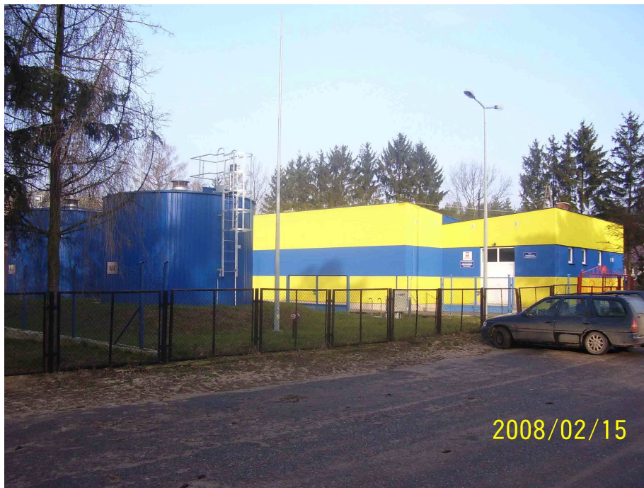
Stacja Uzdatniania Wody w Szulborzu Wielkim
