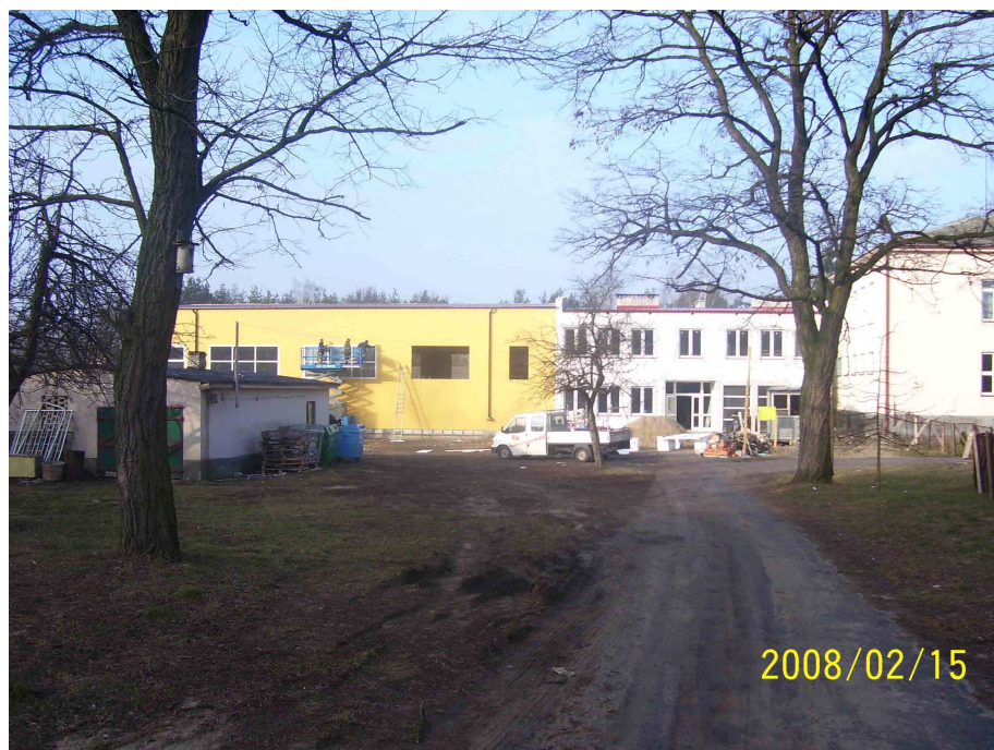
Budynek szkoły wraz z nowobudowaną salą sportową i częścią dydaktyczną
