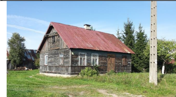
Grędzice – zabudowa przy drodze powiatowej nr 2612W - dz. nr 66
