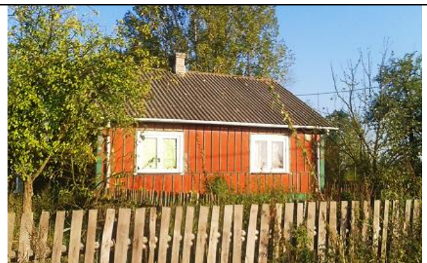
Smolewo-Wieś – zabudowa przy drodze gminnej 260911W – dz. nr 192
