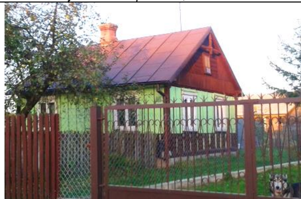
Zakrzewo-Zalesie – zabudowa na działce nr 188/2
