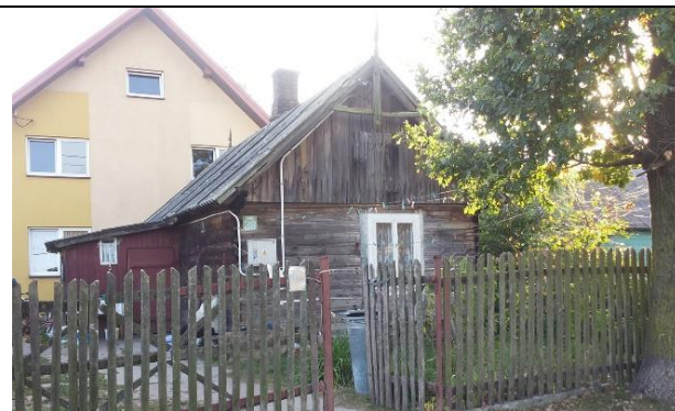
Leśniewo – dom mieszkalny w zabudowie zagrodowej - dz. nr 164
