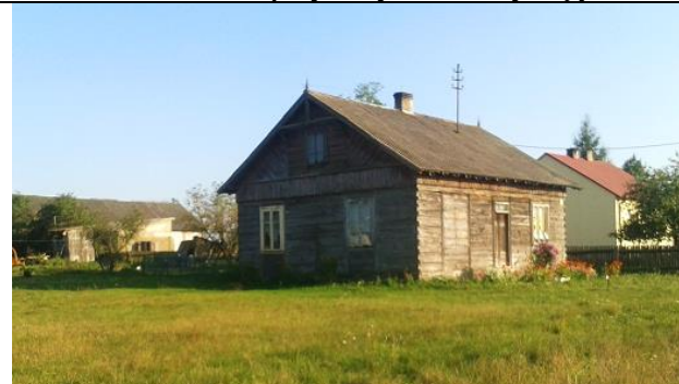
Smolewo-Wieś – zabudowa przy drodze gminnej 260911W – dz. nr 225
