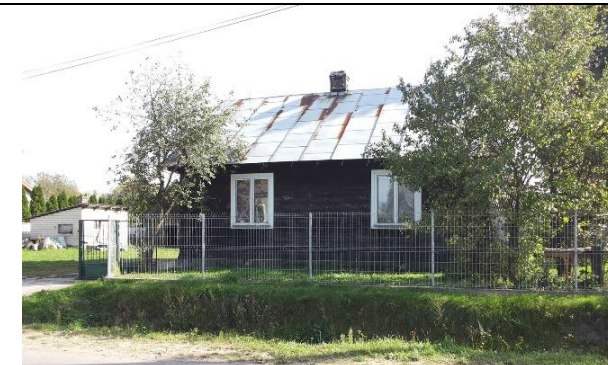
Grędzice – zabudowa przy drodze powiatowej nr 2612W, - dz. nr 93
