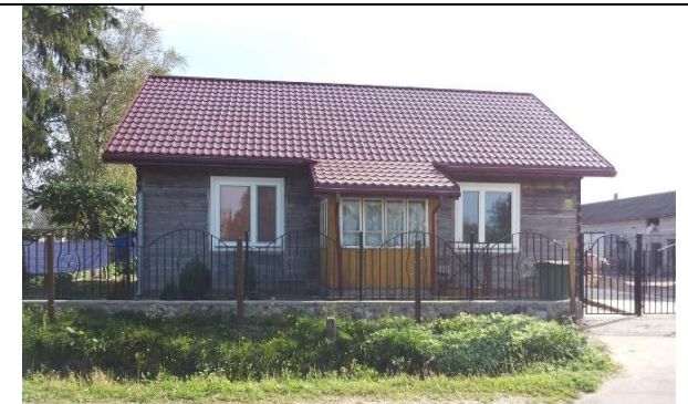
Grędzice – zabudowa przy drodze powiatowej nr 2612W, - dz. nr 94/3
