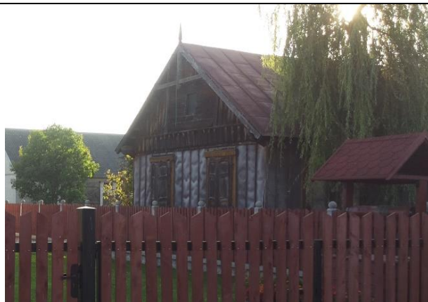
Leśniewo – dom mieszkalny w zabudowie zagrodowej - dz. nr 160
