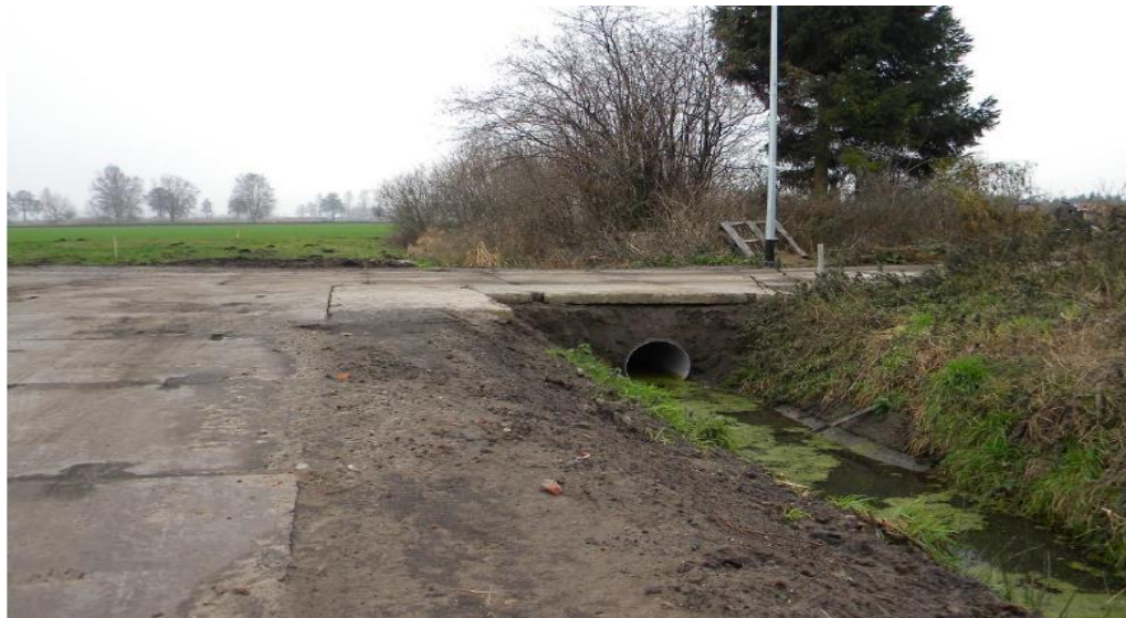
Ryc. 9 Przepust uliczny ul. Makowa w Sztutowie
