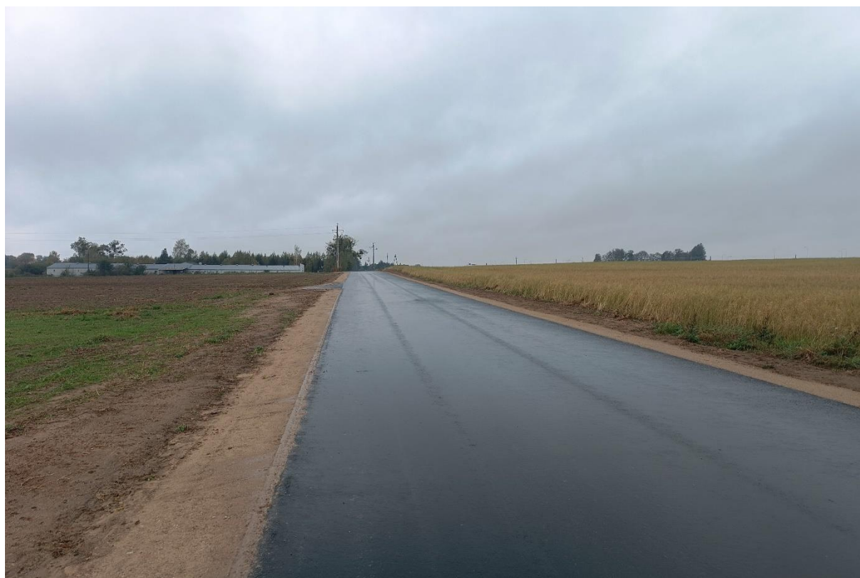
Budowa ul. Miodowej w Gryżlinach
