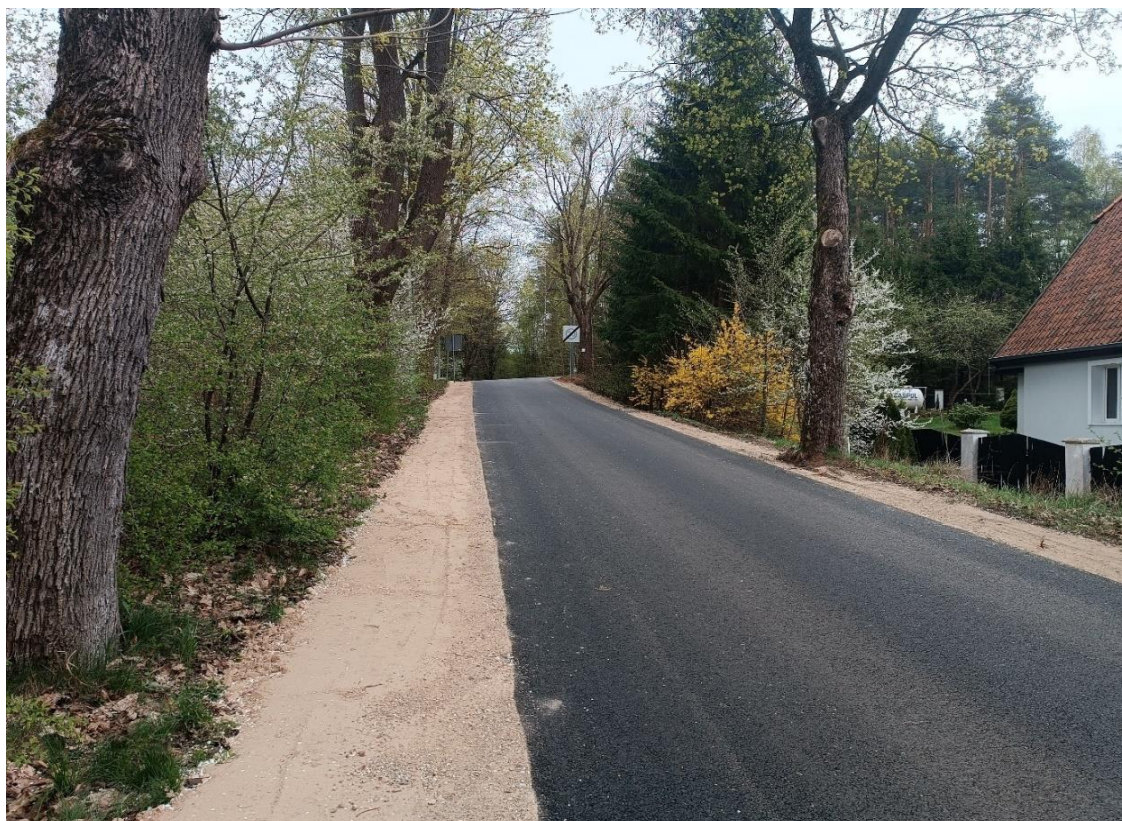
Remont ul. Klonowej w Pluskach
