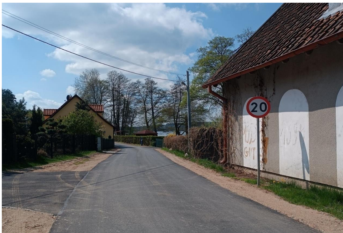
Remont ul. Jeziornej w Pluskach
