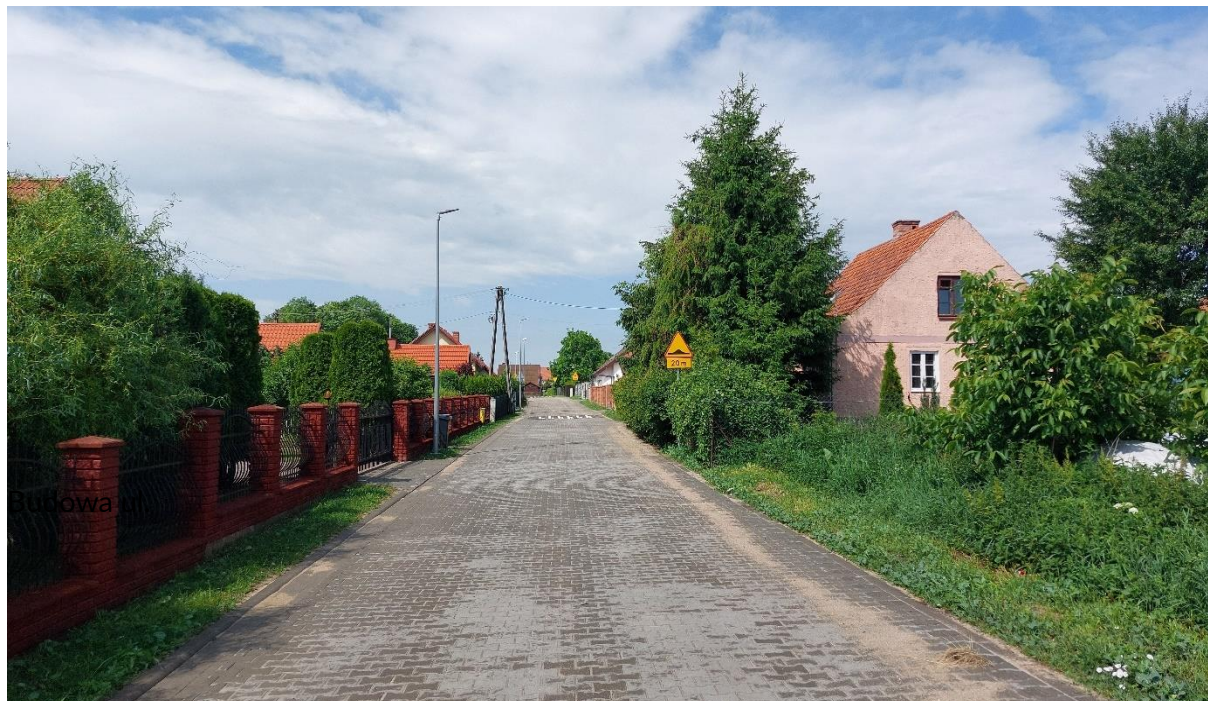
Budowa ul. Grzybowej w Gryżlinach
