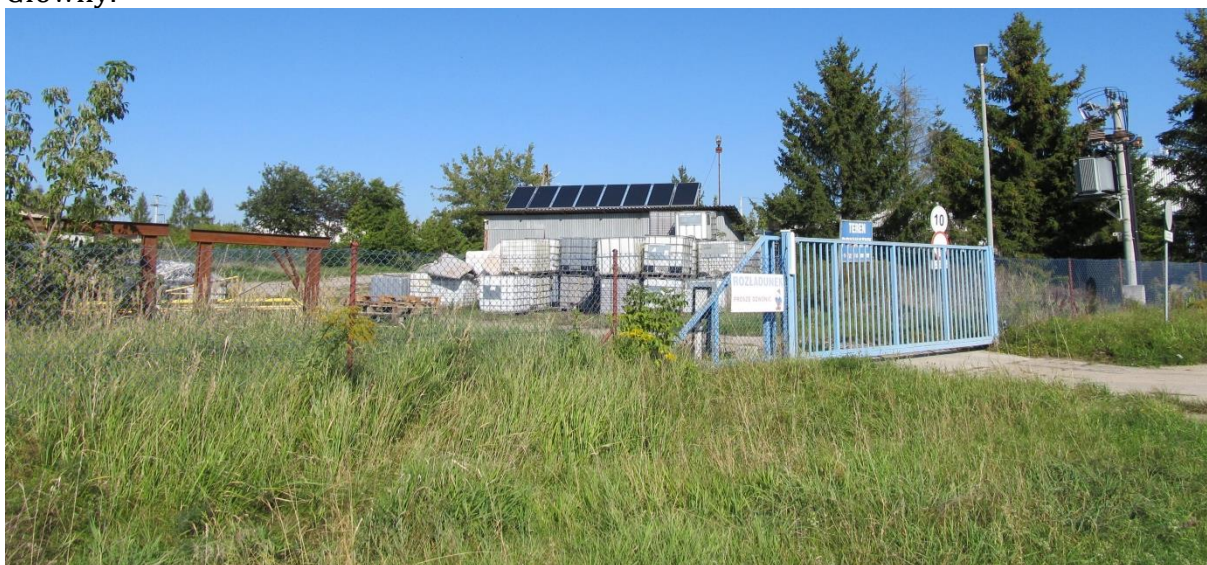
Zdjęcie 7. Zagospodarowana i przekształcona północno-wschodnia część Obszaru II
