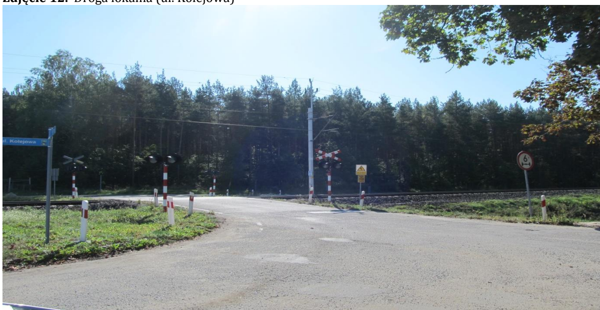
Zdjęcie 13. Przejazd kolejowy
