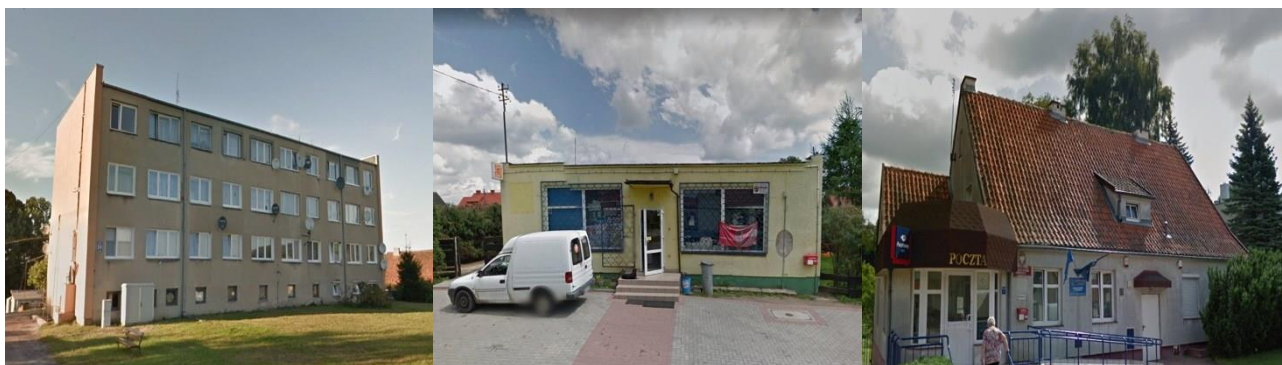
zabudowa wielorodzinna w Bartążku budynek sklepu w Gryżlinach poczta w Stawigudzie
