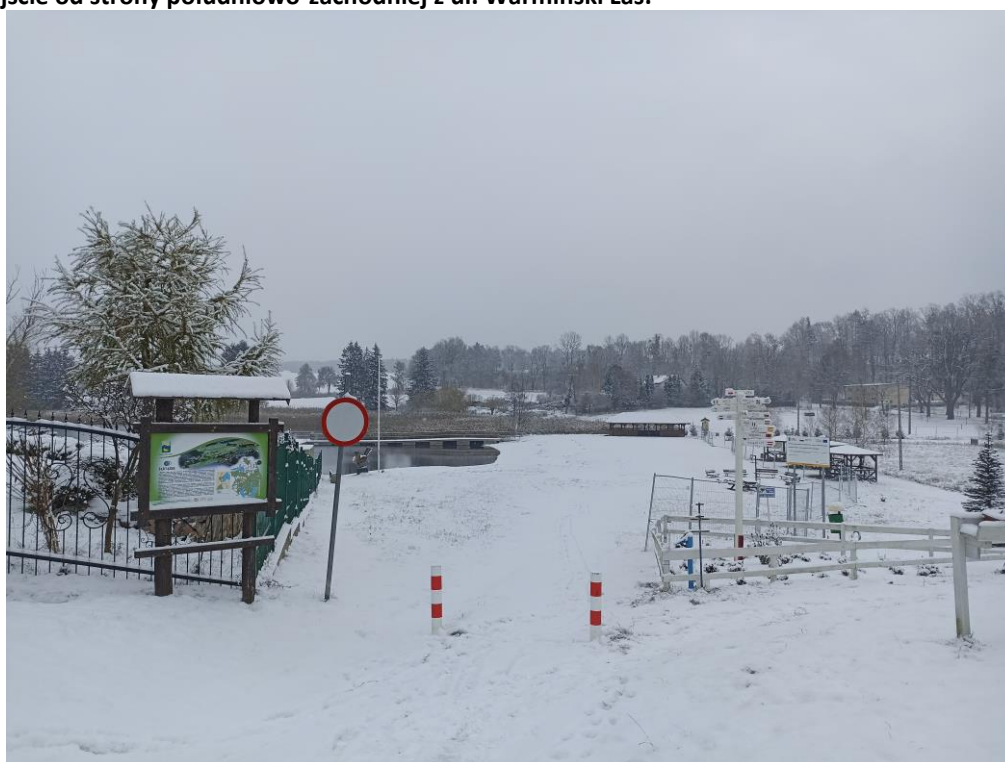
Fot. 1 Zejście od strony południowo-zachodniej z ul. Warmiński Las.
