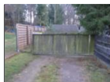
OGRODZENIE TERENU SĄSIEDNIEGO
