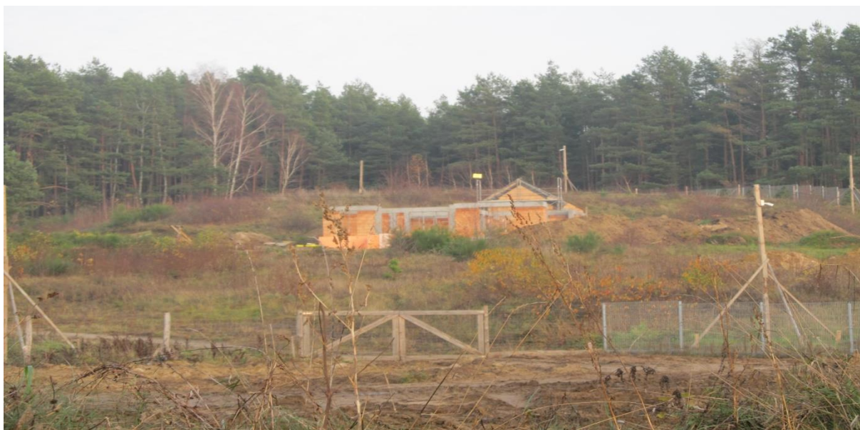
Zdjęcie 6. Zabudowa w fazie budowy położona za południowo-zachodnią granicą Obszaru I
