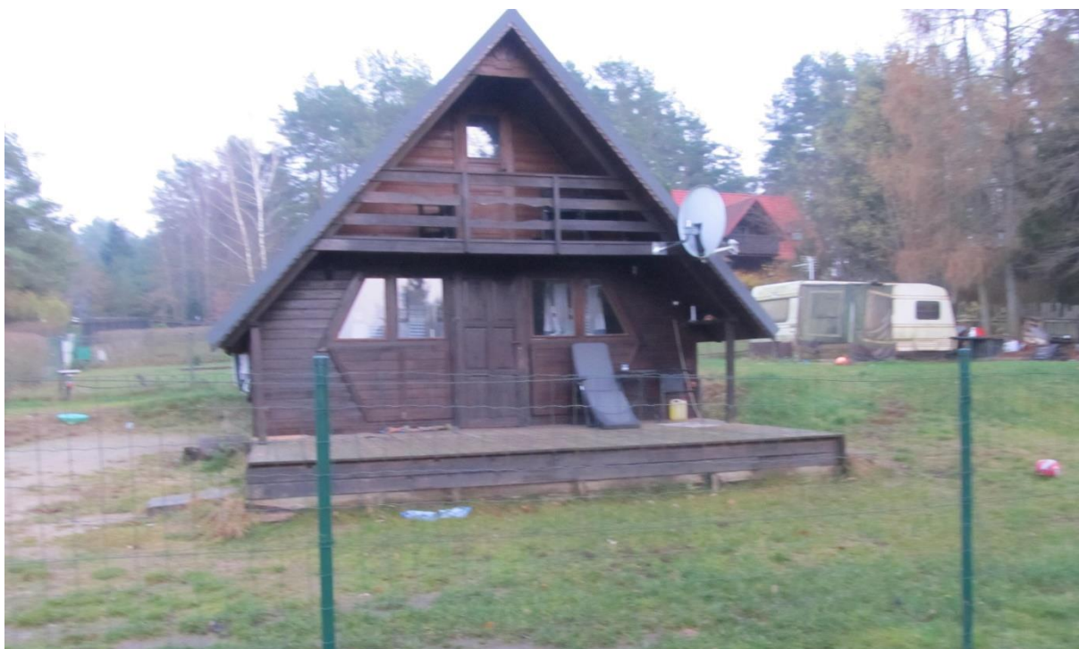
Zdjęcie 21. Istniejąca zabudowa letniskowa
