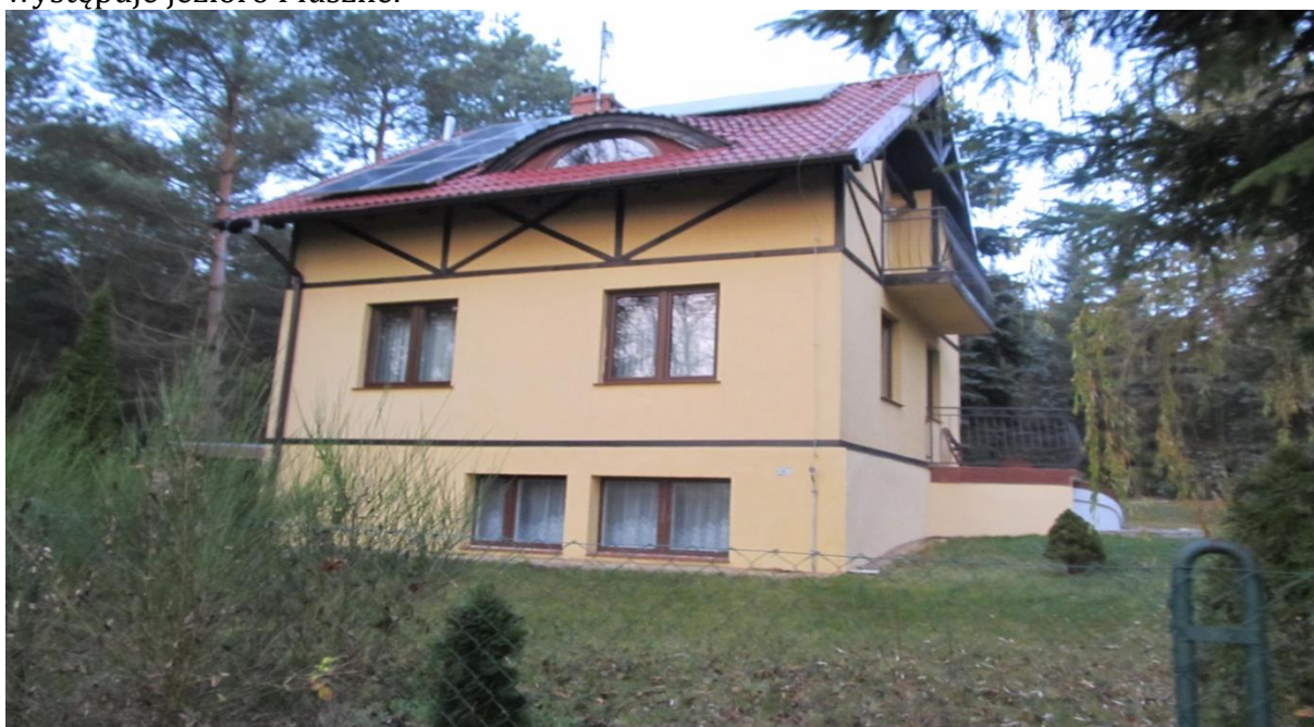
Zdjęcie 14. Istniejąca zabudowa
