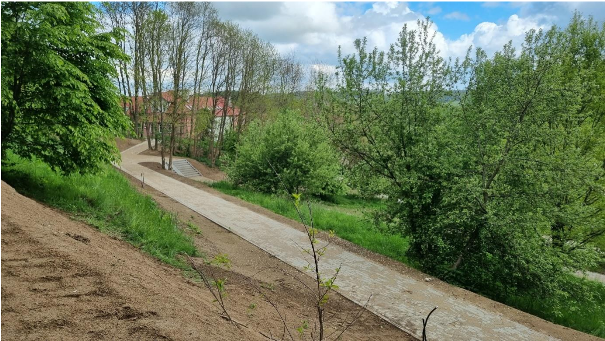
Budowa traktu pieszego wraz z elementami edukacji ekologicznej w Rusi
